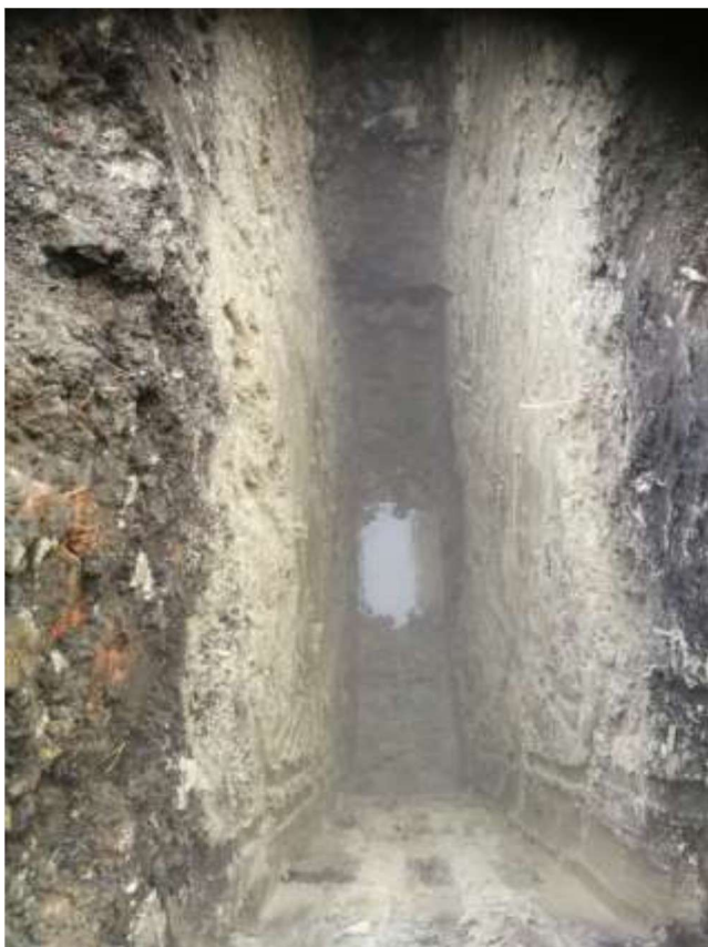
Detail hloubkové sondy č. 1 s vrstvou navážky
