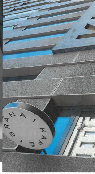
Polyfunkční budova Košířská brána - Praha 5
