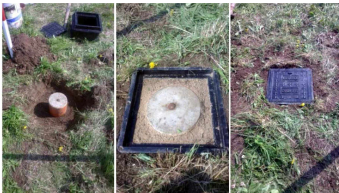
Obrázek 41 Příklad řešení plastové šachty hranaté
