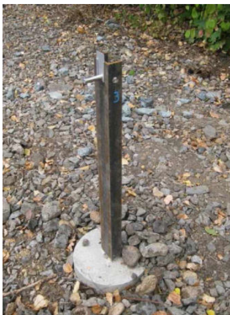
Obrázek 20 Otevřený profil konstrukce sloupku ŽPSV
