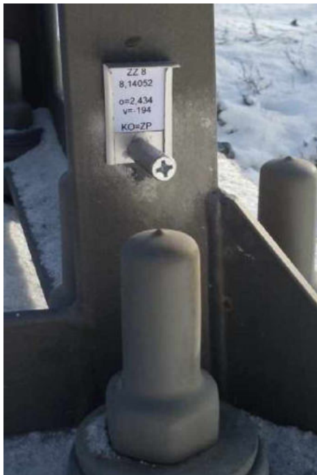
Obrázek 9 Konzolová značka na podpěře trakčního vedení
