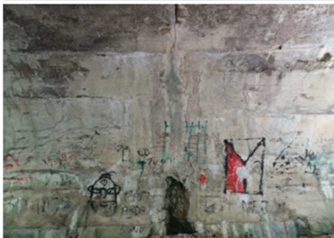
Foto č. 6 Konstrukce K 03 – líc střed nad O 02 degradovaný beton kolem pracovní spáry.
