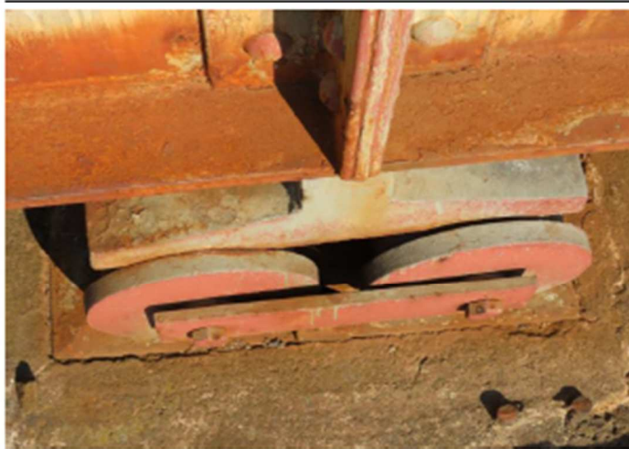
Foto č. 3 Konstrukce K 02
