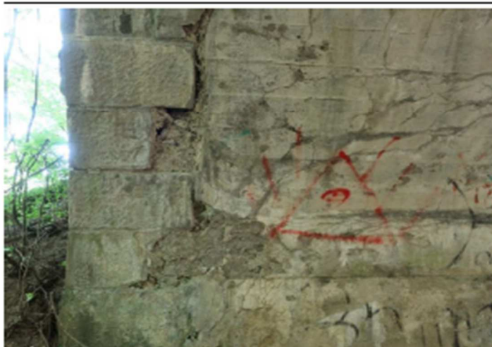
Foto č. 7 Konstrukce K 02 – lic nad O 02 vlevo, degradovaný beton, trhliny.
