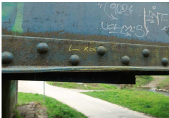
Foto č. 1 Konstrukce K 01 – levý hlavní nosník, konec – deformace
