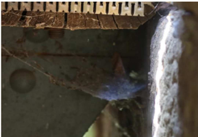
Foto č. 1 Konstrukce K 01 – levý podélník - naražení na závěrnou zeď opěry O 02
