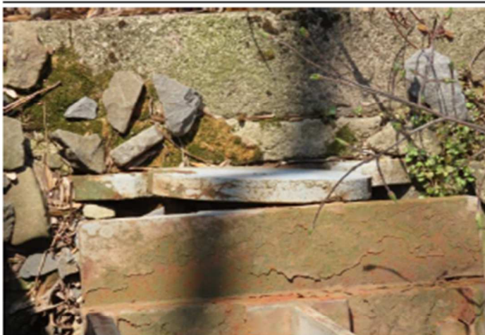
Foto č. 4 Konstrukce K 04
