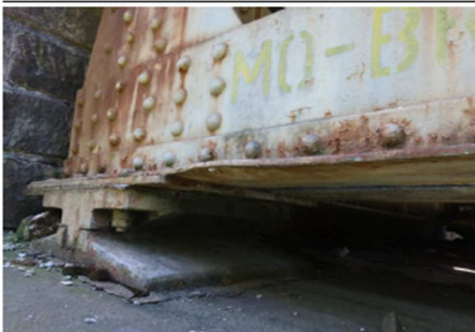
Foto č. 2 Konstrukce K 01 pravý hlavní nosník nad O 01 deformace dolní pásnice
