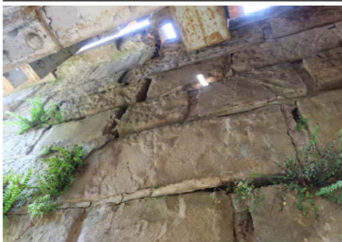
Foto č. 9 Pilíř P 01 2. otvor závěrná zeď vpravo – vydrolené spárování
