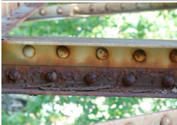
Foto č. 3 Konstrukce K 02 – 1. příčné ztužení vpravo korozní oslabení dolní pásnice.
