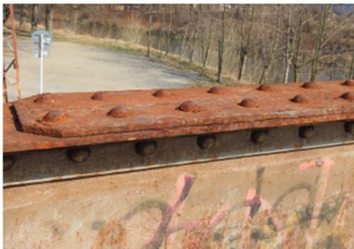
Foto č. 1 Konstrukce K 01
