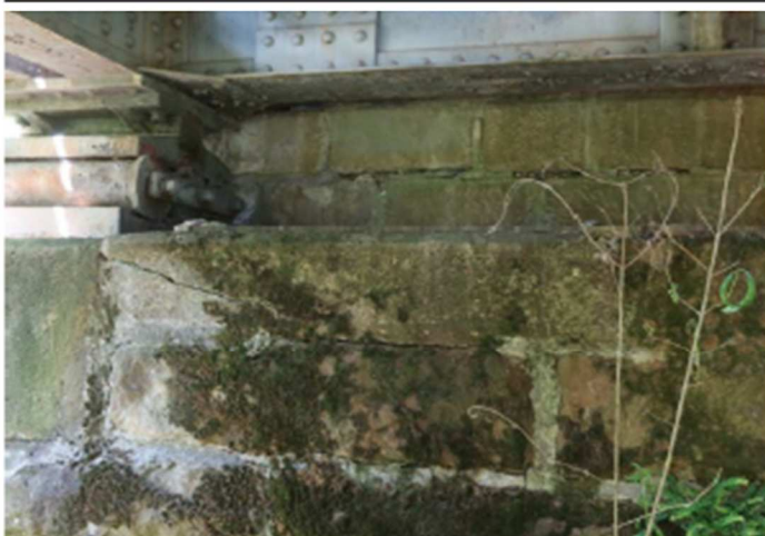
Foto č. 3 Opěra O 02 – úložný práh vlevo trhлина
