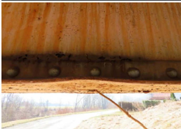
Foto č. 2 Konstrukce K 01
