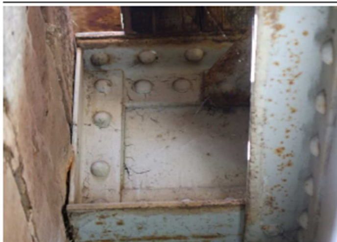
Foto č. 4 Konstrukce K 02 – pravý podélník nad P 02 naražení na závěrnou zeď
