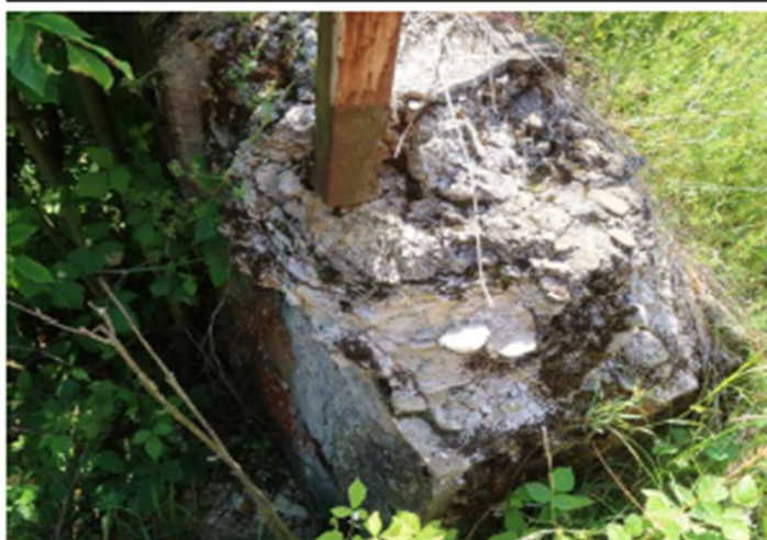
Foto č. 8 Opěra O 01 Křídlo vlevo, 1. sloupek, degradovaný beton
