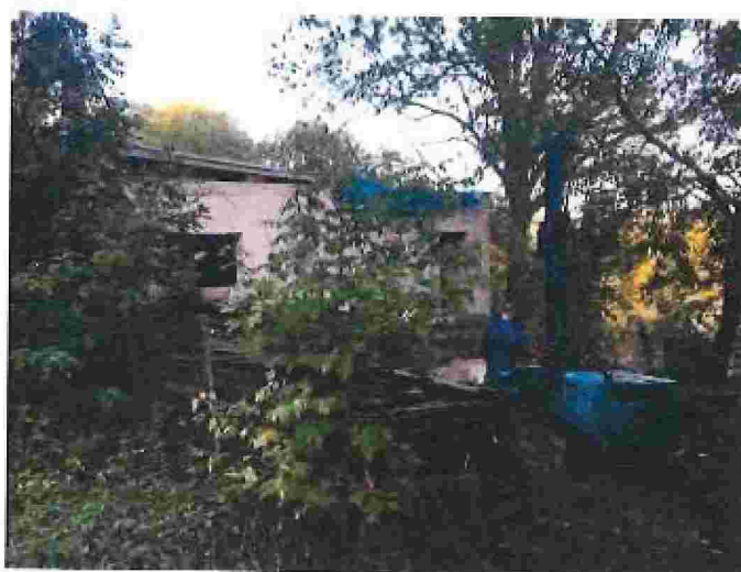
Foto č.4: Vrtné práce
