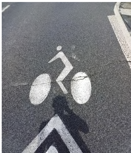
Obr 2: silnice II/110 – obnova CI (km cca 3,600–3,754)
