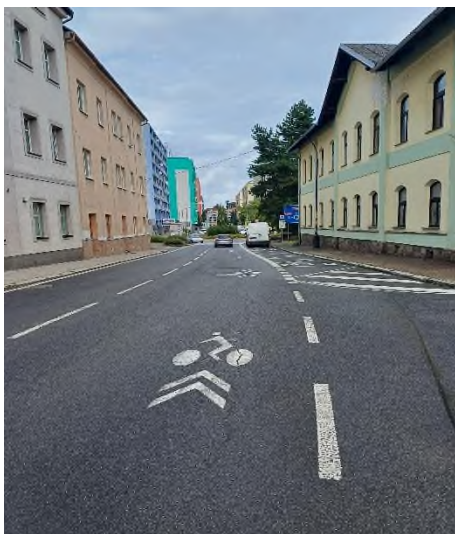
Obr 1: silnice II/110 – obnova CI (km cca 3,600–3,754)
