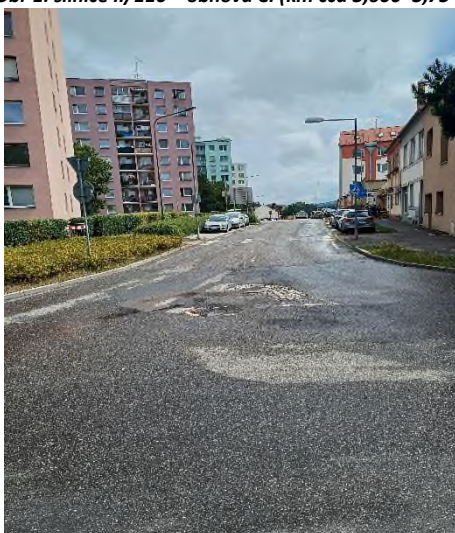
Obr 3: silnice II/110 – pohled z OK
