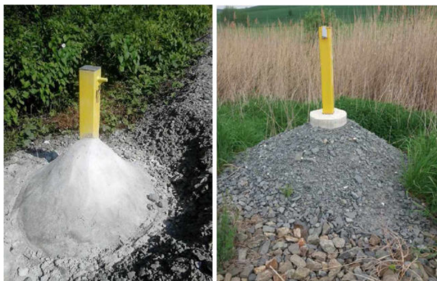
Obrázek 17 Řešení zhotovitele pro zvýšení stability zajišťovací značky
