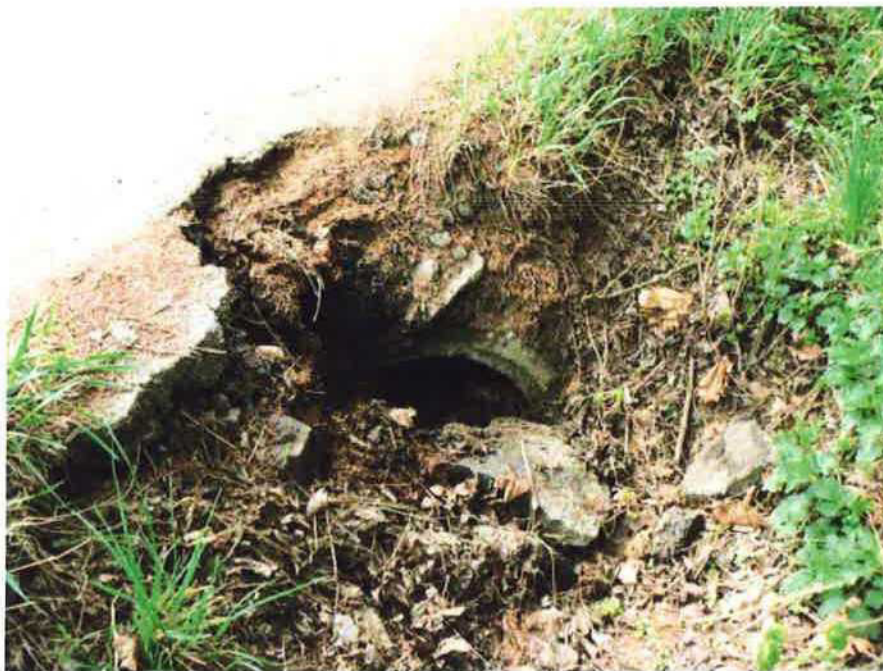
II/105 propustek staničení cca 30,700 km
