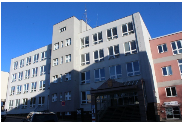
Obrázek 2 – Pohled I – stará budova
