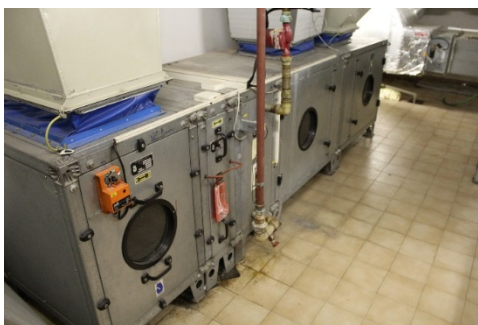
Obrázek 8 - VZT pro větrání garáže
