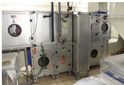
Obrázek 9 – VZT pro větrání zasedací místnosti
