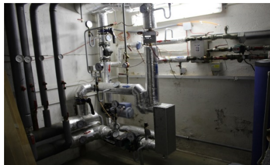
Obrázek 36: Výměníková stanice
