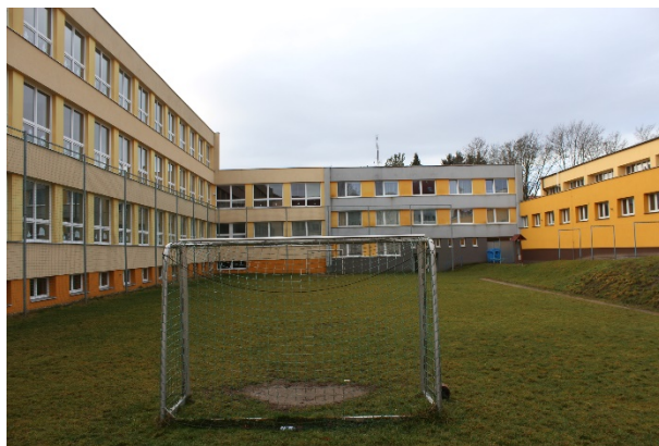
Obrázek 33: Pohled II – Pavilon A a B
