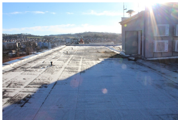
Obrázek 5 – Střecha staré budovy
