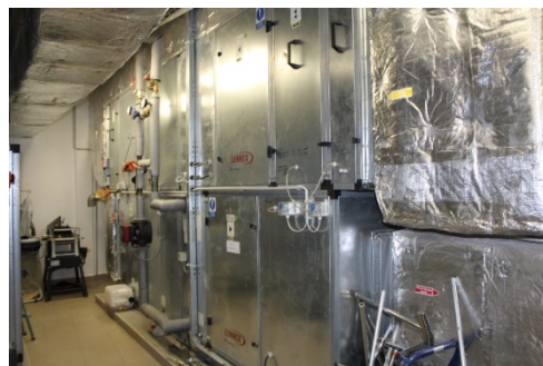
Obrázek 24 – VZT jednotka pro kuchyň
