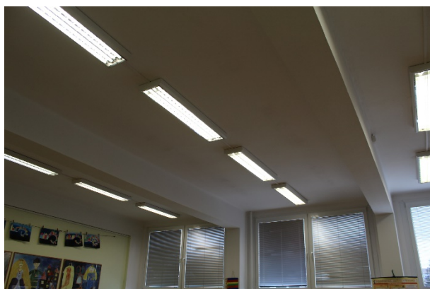
Obrázek 42: Zářivkové osvětlení učeben
