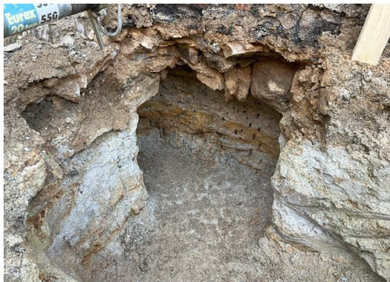
Obr. 1 Pohled na západní stěnu výkopu pro šachtici výtahu (12.03. 2025)
