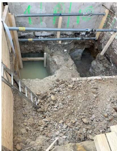
Obr. 2 Pohled na výkopy pro výtah od S; východní šachtice s přítoky podzemní vody (07.03. 2025)
