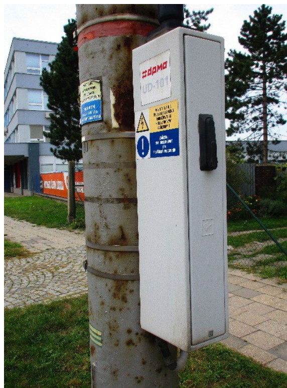
Obr. 39: Motorový pohon odpojovače
