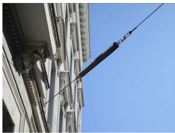
Obr. 8: Pružinový napínač
