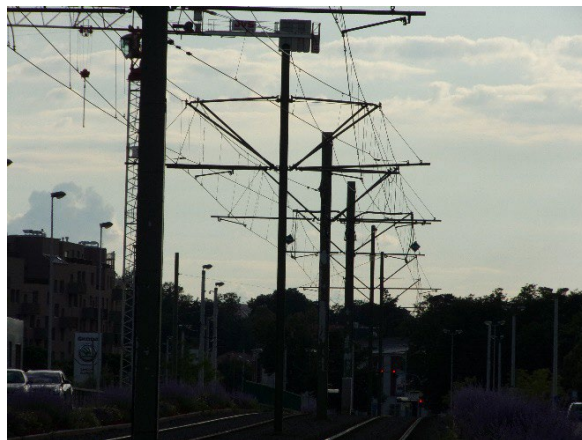
Obr. 2: Výměnný úsek řetězovkového vedení
