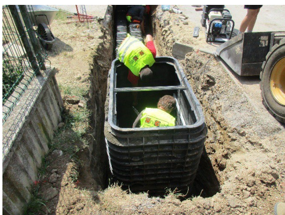
Obr. 48: Kabelová komora
