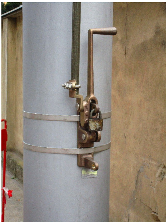
Obr. 38: Ruční pohon odpojovače
