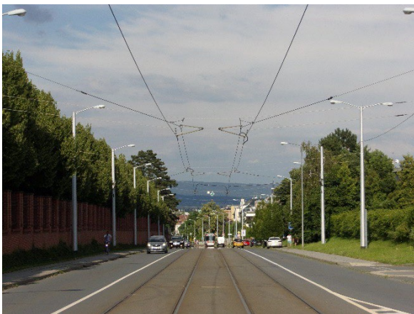
Obr. 1: Výměnný úsek prostého vedení
