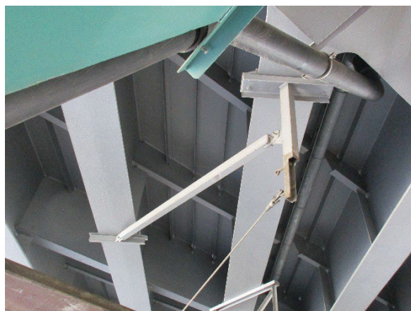
Obr. 20: Trakční vedení pod mostem
