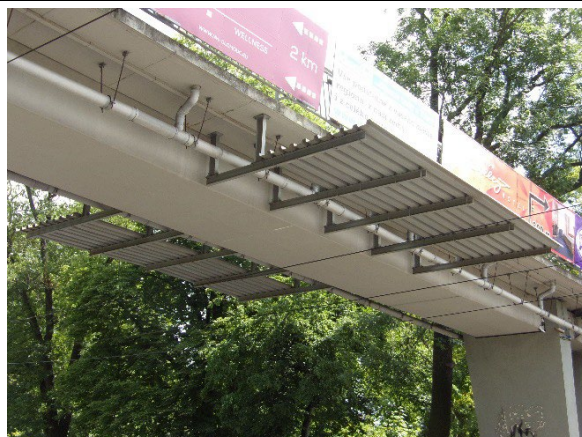
Obr. 12: Protidotykové zábrany upevněné na konstrukci mostu
