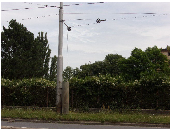
Obr. 5: Pohyblivé kotvení prostého vedení kladkostrojem v poměru 1:2
