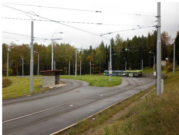
Obr. 4: Pevné kotvení řetězovkového vedení
