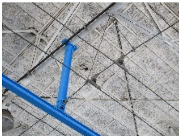
Obr. 26: Trakční vedení na nosné konstrukci budovy
