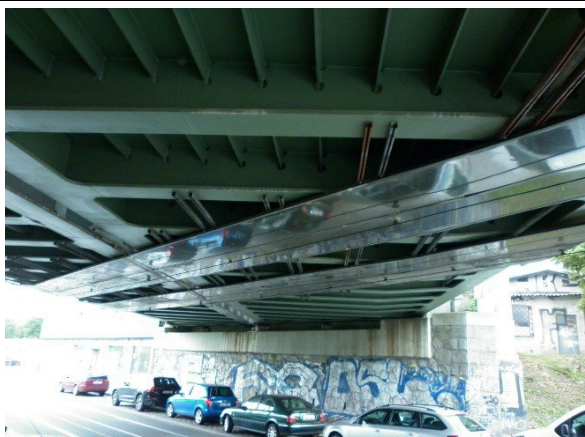
Obr. 11: Ochranné desky na nosné konstrukci pod železničním mostem
