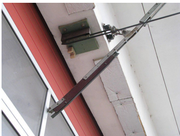
Obr. 13: Konstrukce sklopné troleje při spuštěných rolovacích vrátech
