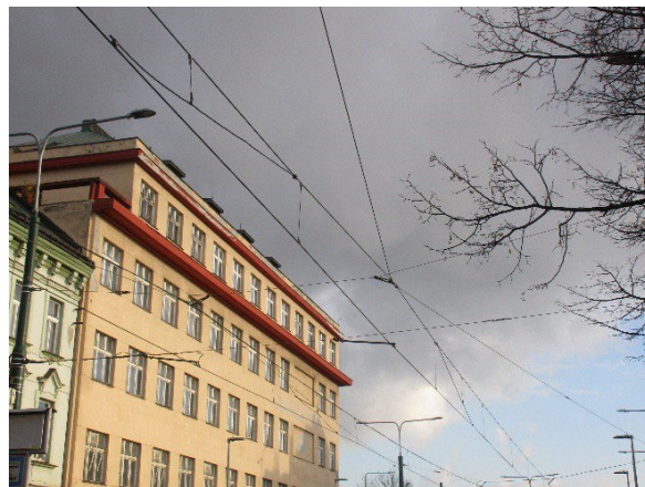
Obr. 10: Pevný bod řetězovkového vedení
