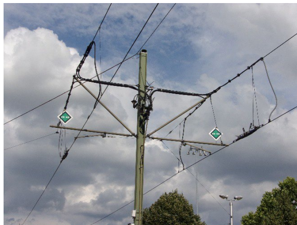
Obr. 43: Propojovací kabely na konzoli
