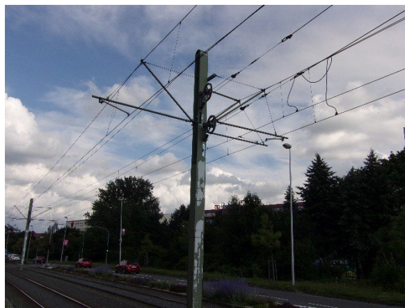
Obr. 6: Pohyblivé kotvení řetězového vedení západkovým kladkostrojem v poměru 1:3
