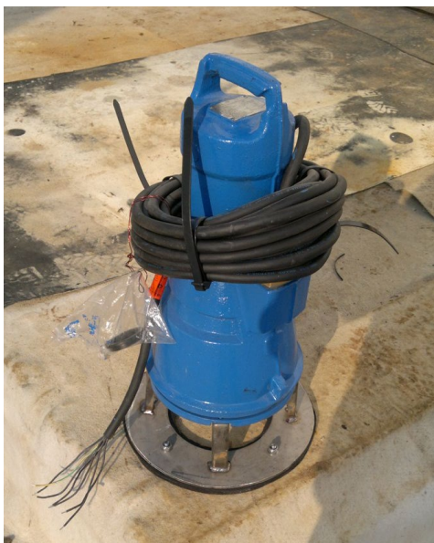
Obr. 4.6 Střešní čerpadlo po rekonstrukci včetně nového podstavce
