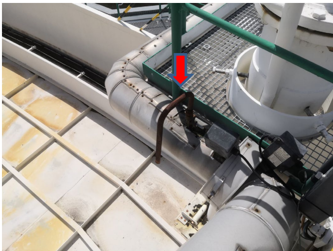
Obr. 3.10 Současný stav systému zavzdušnění výtlaku st. čerpadla
