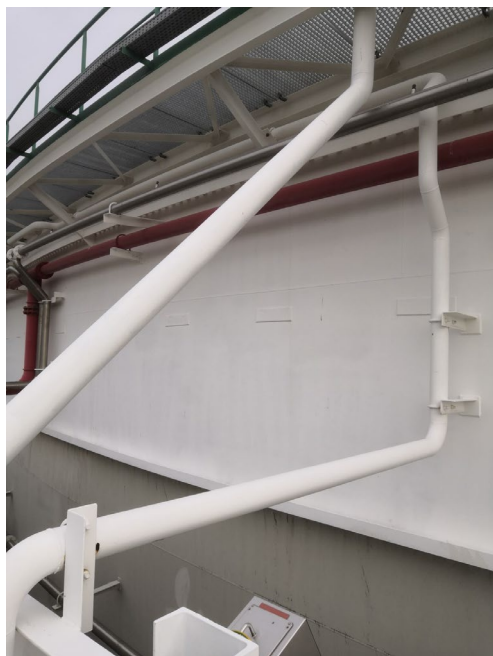
Obr. 3.14 Umístění přechodu odkalovacího potrubí přes meziprostor
