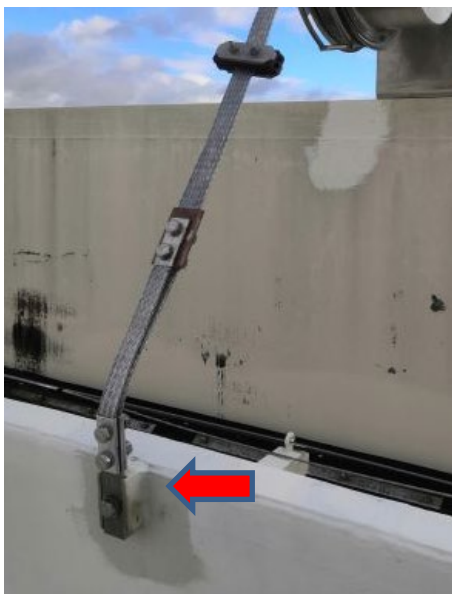
Obr. 4.8 Umístění zemního bodu na pěnové hradítko
