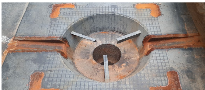
Obr. 3.8 Stav po provedené úpravě
