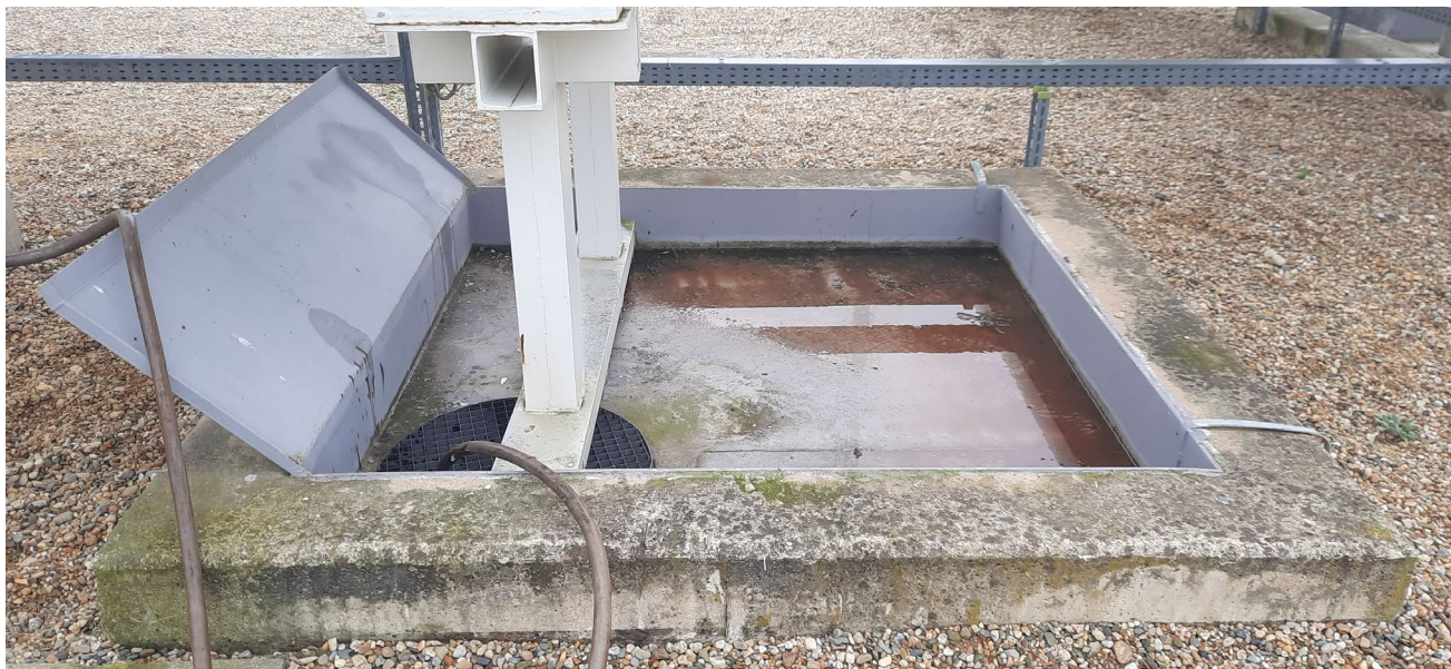
Obr. 7.1 Železobetonová vana s ocelovou výstelkou
