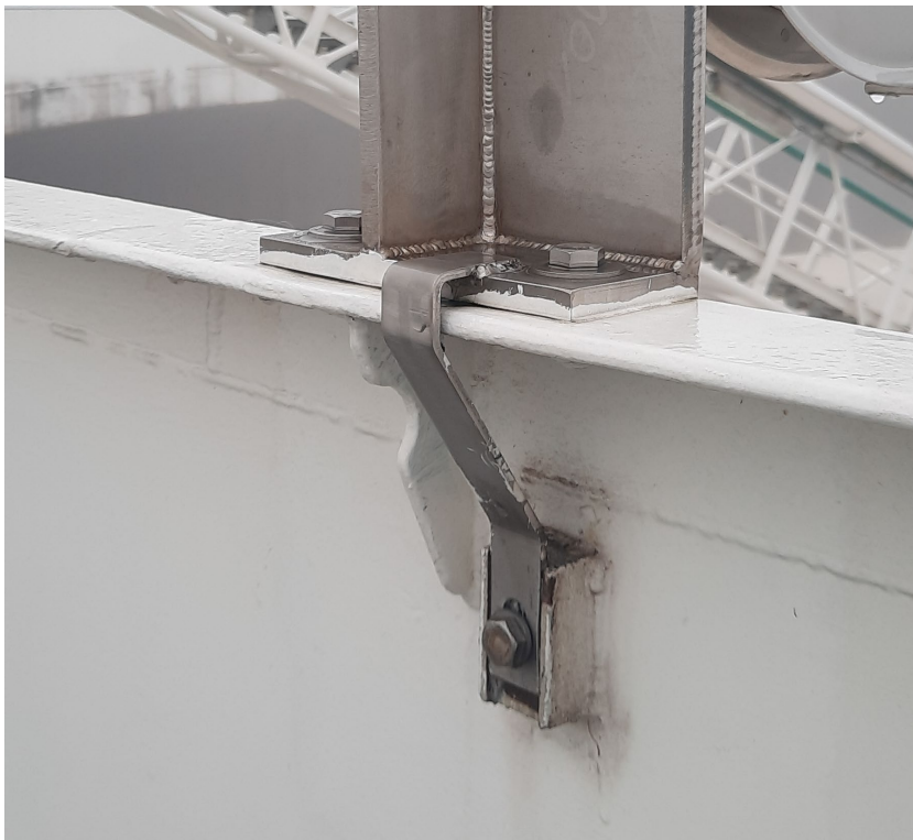
Obr. 3.1 Instalace zemního bodu a výztužného žebra
