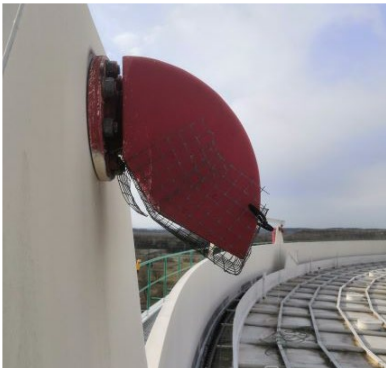
Obr. č. 3 Zakrytí pěnové proudnice (chrliče)
