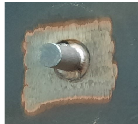
Obr. 3.16 Přivaření geodetického bodu na stěnu jímky/nádrže
