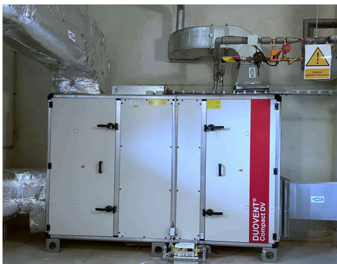
Obr. 2.2.4.: instalace VZT zařízení
