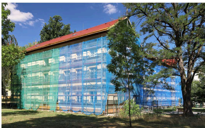
Obr. 2.2.1.: rekonstrukce obvodového pláště
