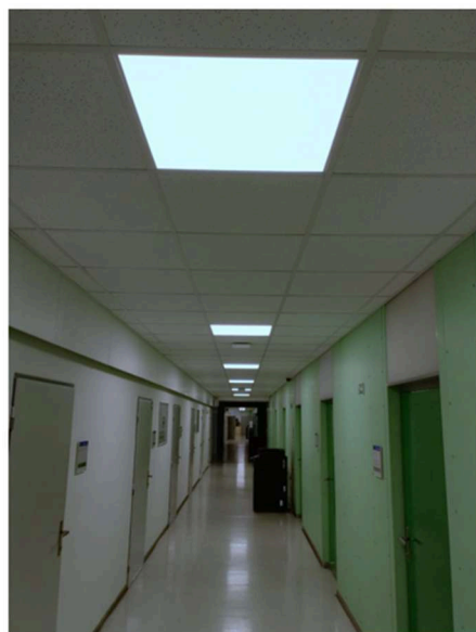
Ilustrativní foto – vzduchovody v podhledu
