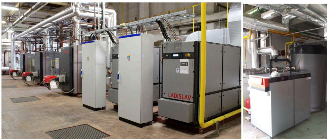
Obr. 2.2.2.: rekonstrukce zdroje tepla
