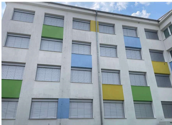
Obr. 2.2.5.: instalace stínicí techniky
