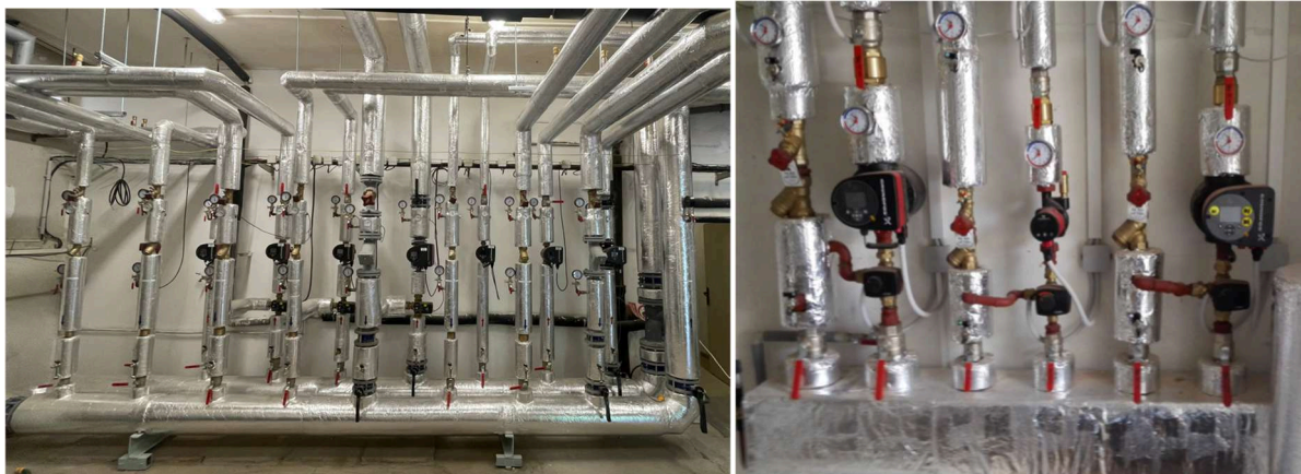
Obr. 2.2.3.: rekonstrukce rozdělovače a sběrače tepla
