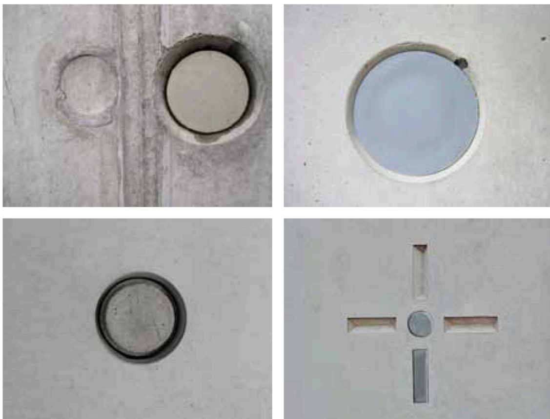
(23) Obr. F.2 – Různé způsoby uzavření spínacích otvorů
