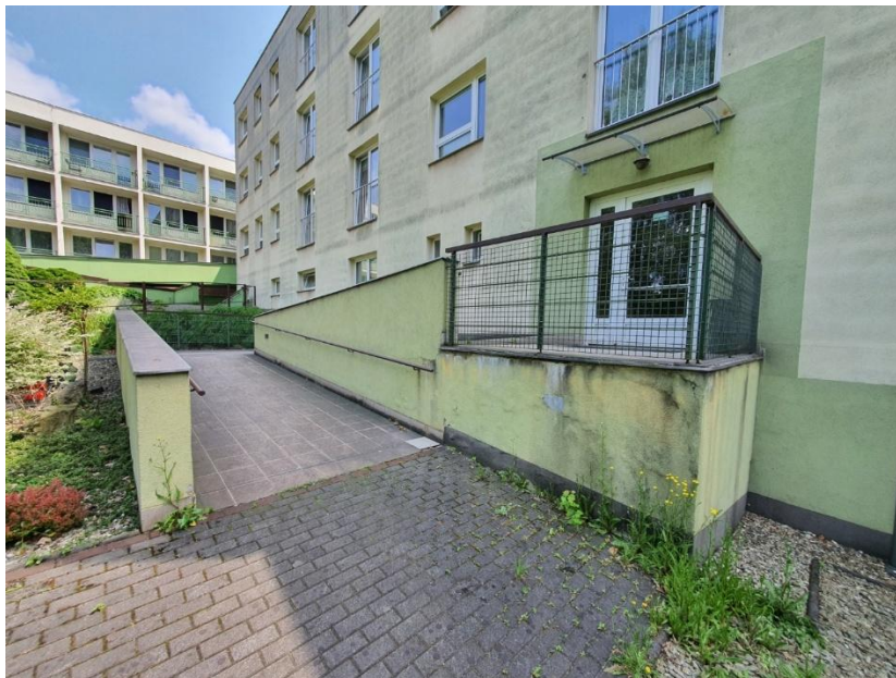
2. Fotodokumentace venkovní rampy – stávající stav
