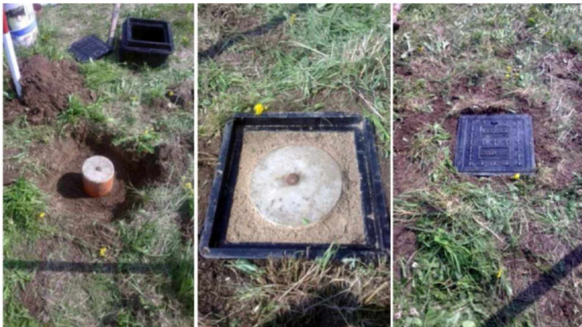
Obrázek 41 Příklad řešení plastové šachty hranaté
