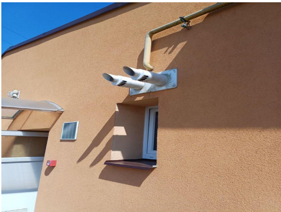
Foto č. 4 – Vyústění odtahu spalin
