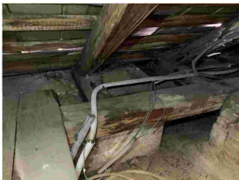
Obr. 3: Stávající dřevěný krov, degradace
