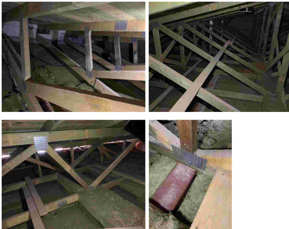
Obr. 1: Stav sbíjených vazníků na ZŠ Masarykova, ztužení a střední ocelová podpora
