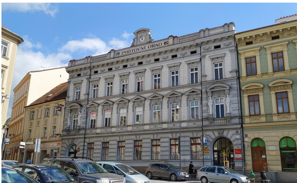
Hlavní průčelí pošty do Horního náměstí
