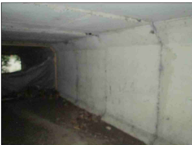
Pohled na OP1 z LS Ostraněná přepážka z geotextilie.
