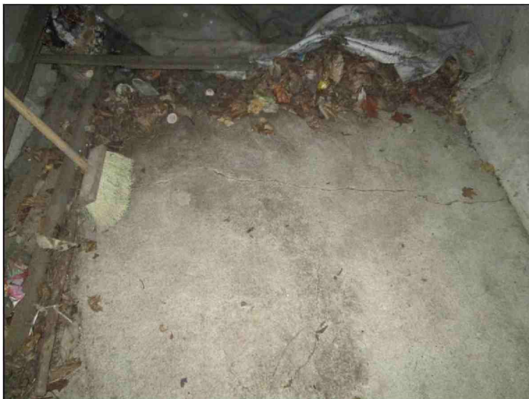
Pohled na spodní příčel - podélná trhлина
