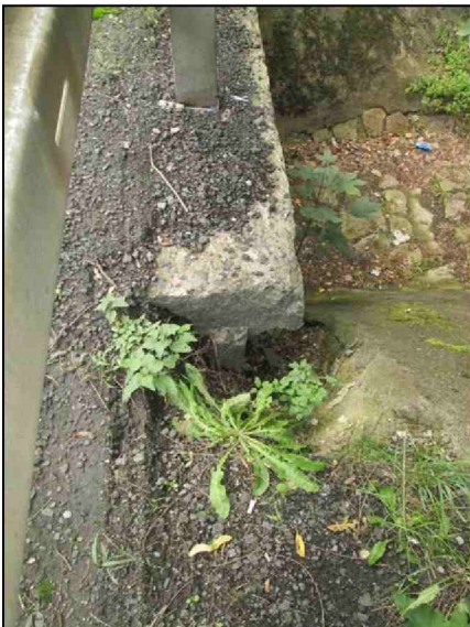
Pravá strana nad OP1 Chybí systém povrchového odvodnění Vymletá erozní rýha
