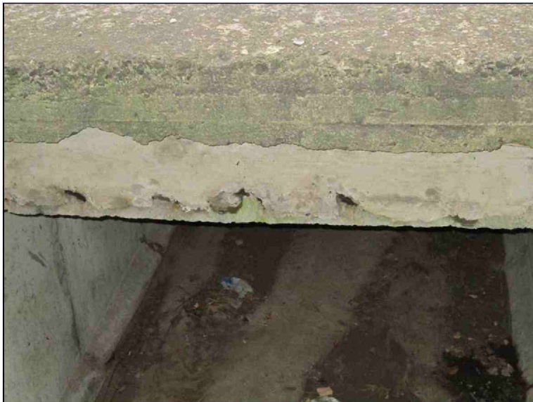
Pohled na most z LS Separace dobetonávky čela
