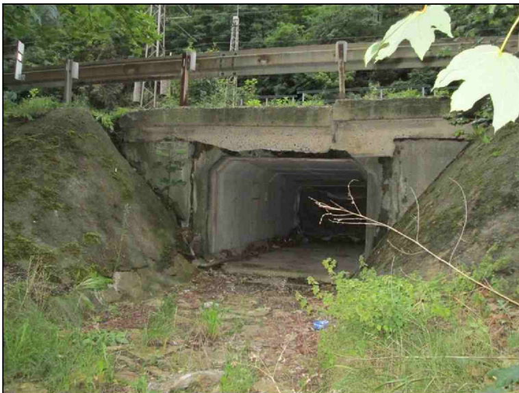
Pohled na most z PS na OP1 a křídlo Otevřená svislá dilatační spára, vysunutě křídlo Rozpad obetonávky svahového kužele
