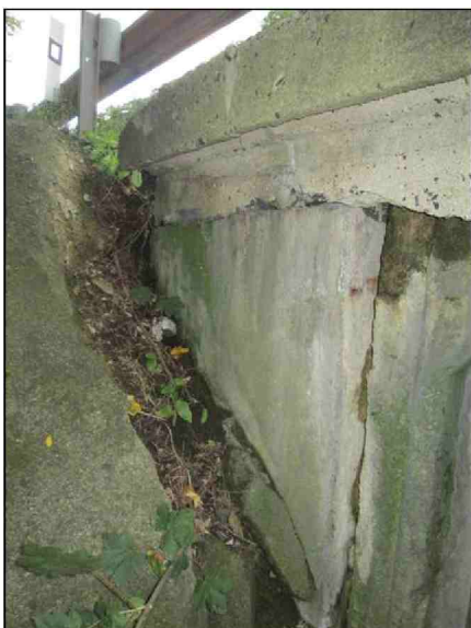
Pohled na most z PS na OP1 a křídlo Otevřená svislá dilatační spára, vysunutě křídlo Rozpad obetonávky svahového kužele
