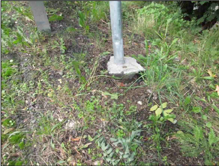
Pravá strana nad OP1 Chybí systém povrchového odvodnění Vymletá erozní rýha
