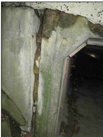
Pohled na most z PS na OP1 a křídlo Otevřená svislá dilatační spára, vysunutě křídlo
