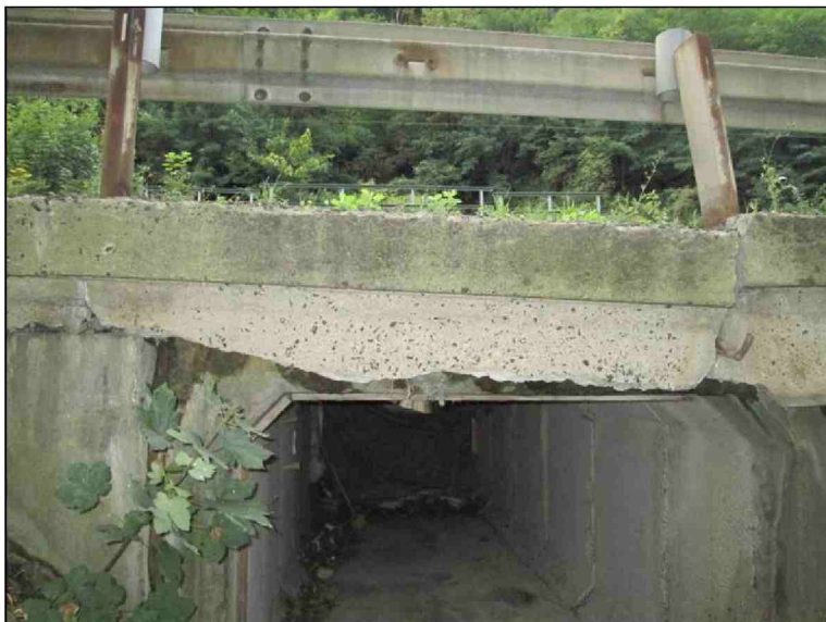
Pohled na most z PS na OP1 a křídlo Otevřená svislá dilatační spára, vysunutě křídlo
