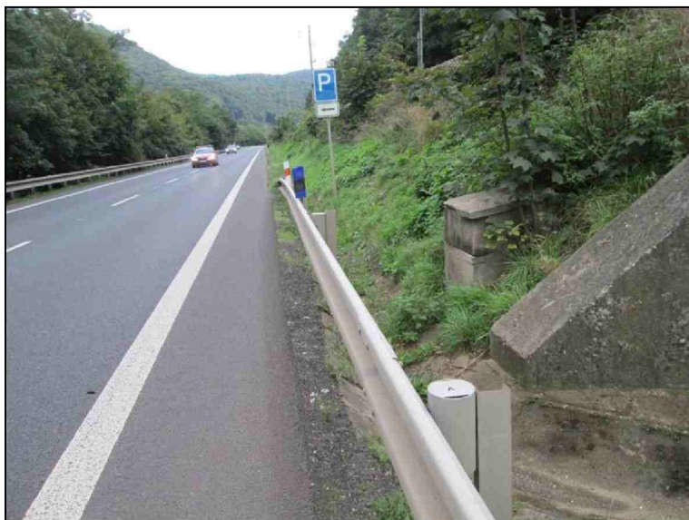
Levá strana Nevyhovující zádržný systém Chybí zábradlí
