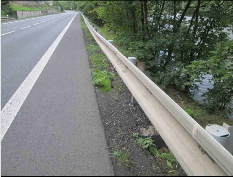
Pohled ve směru staničení.
