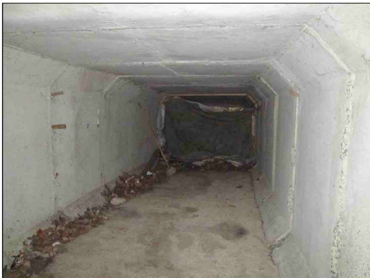
Pohled do mostního otvoru z PS Zaslepení otvoru
