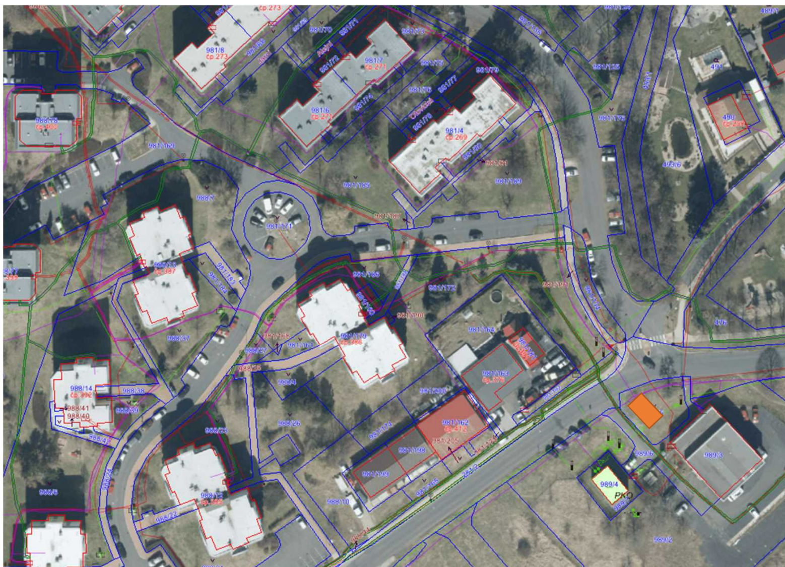
Chlumeč IV. Etapa – místo pro kontejner na parcele p.p.č. 989/5 v k.ú. Chlumeč před odstavným parkovištěm u křižovatky ulic Zalužanská a Stradovská
