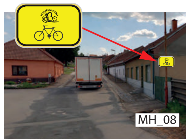
INSTALACE 2x IS21a (MLYNÁŘSKÁ) SPOLEČNĚ PRO OBA SMĚRY NA SLOUP VEŘEJNÉHO OSVĚTLENÍ
