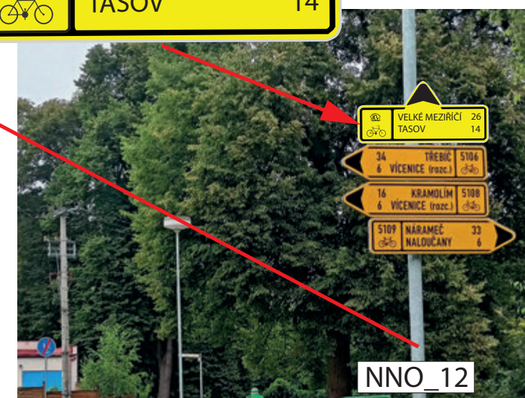
INSTALACE IS19a (MLYNÁŘSKÁ) NA SLOUP VEŘEJNÉHO OSVĚTLENÍ UMÍSTĚNÍ NAD STÁVAJÍCÍ ZNAČENÍ
