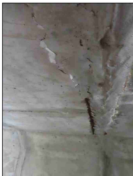
Pohled směrem k OP2 zleva 2. díl-obnažená výztuž
