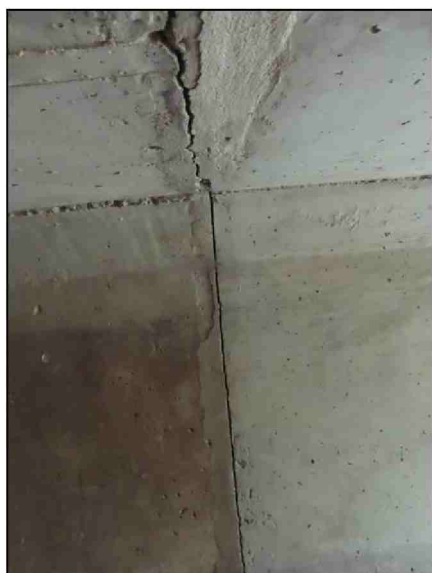
Pohled směrem k OP2 PS 7-8 díl- otevřená spára
