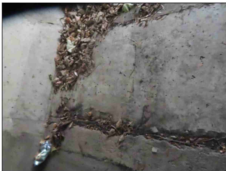
Pohled na LS Spodní příčel 8 díl- otevřené spáry- výztuž
