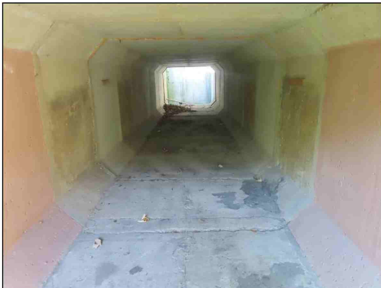
Pohled na OP1 LS Nezatěsněná svislá spára Odpadlá dobetonávka čela
