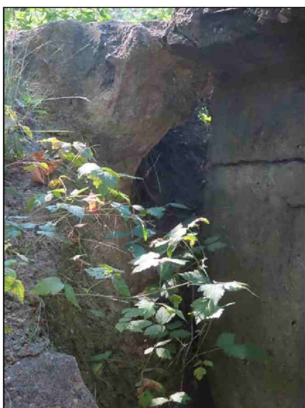
Pohled na OP1 a křídlo z PS Vymletá obetonávka svahového kužele- na konci křídla a podél římsy
