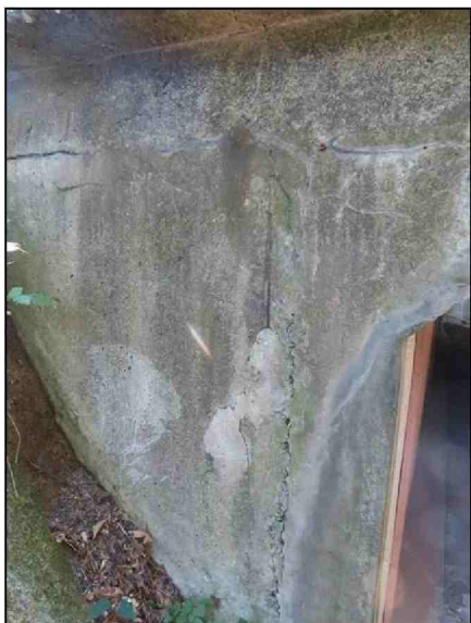
Pohled na OP1 a křídlo zprava Trhliny v omítce
