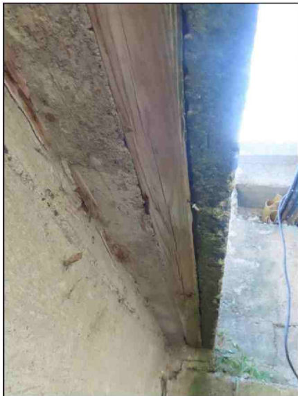
Pohled směrem k OP1 LS Ponechaná lišta z bednění římsy
