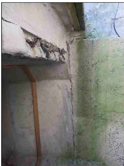
Pohled na OP1 LS Nezatěsněná svislá spára Odpadlá dobetonávka čela
