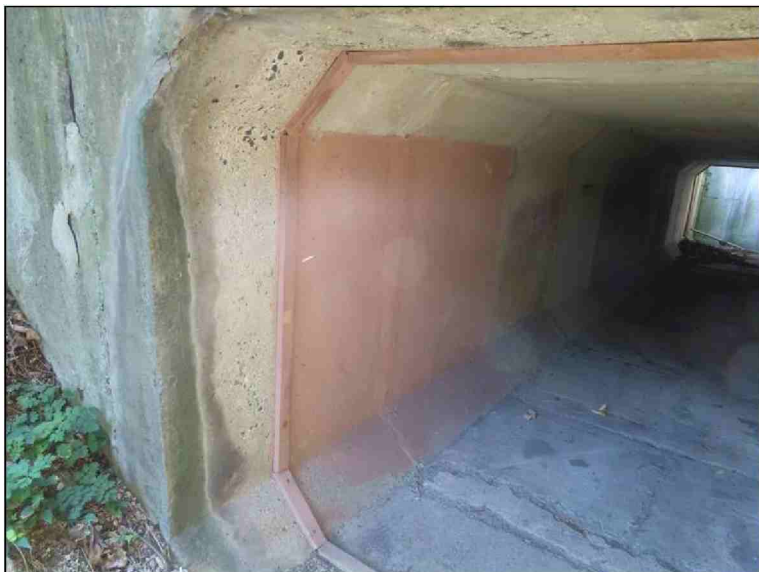
Pohled na OP1 a křídlo zprava Trhliny v omítce
