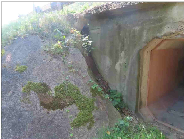
Pohled na OP1 a křídlo z PS Vymletá obetonávka svahového kužele- na konci křídla a podél římsy
