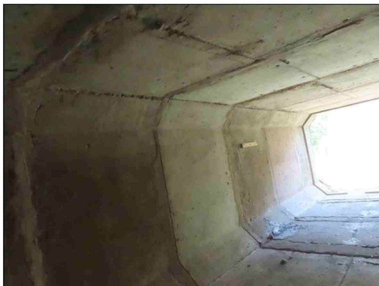
Pohled směrem k OP2 PS 7-8 díl- otevřená spára
