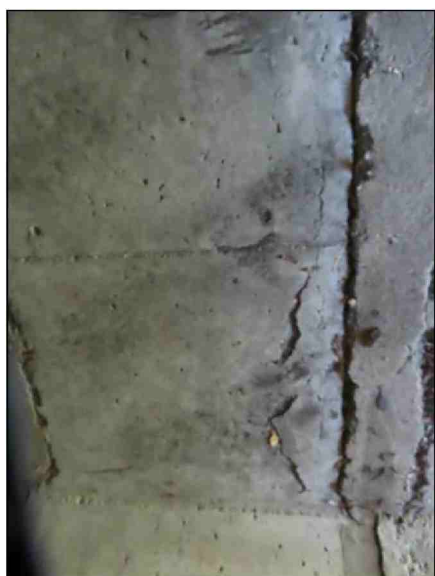
Pohled na LS Spodní příčel 8 díl- otevřené spáry- výztuž
