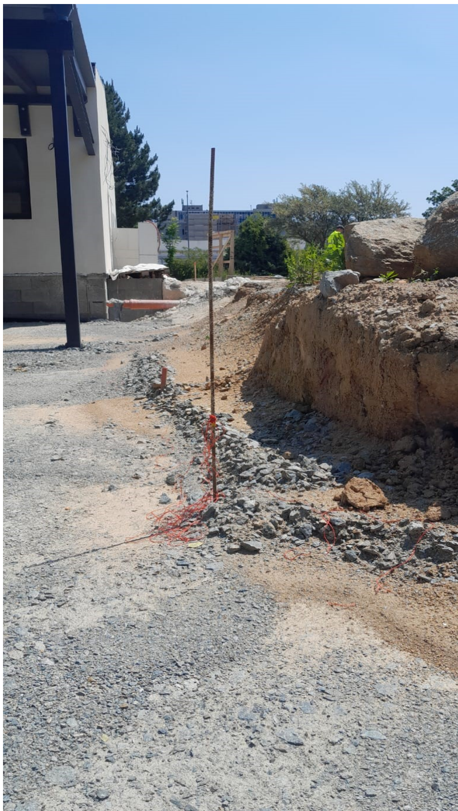
Místo kde je nutné vyřešit výškový rozdíl terénu pomocí opěrné zdi
