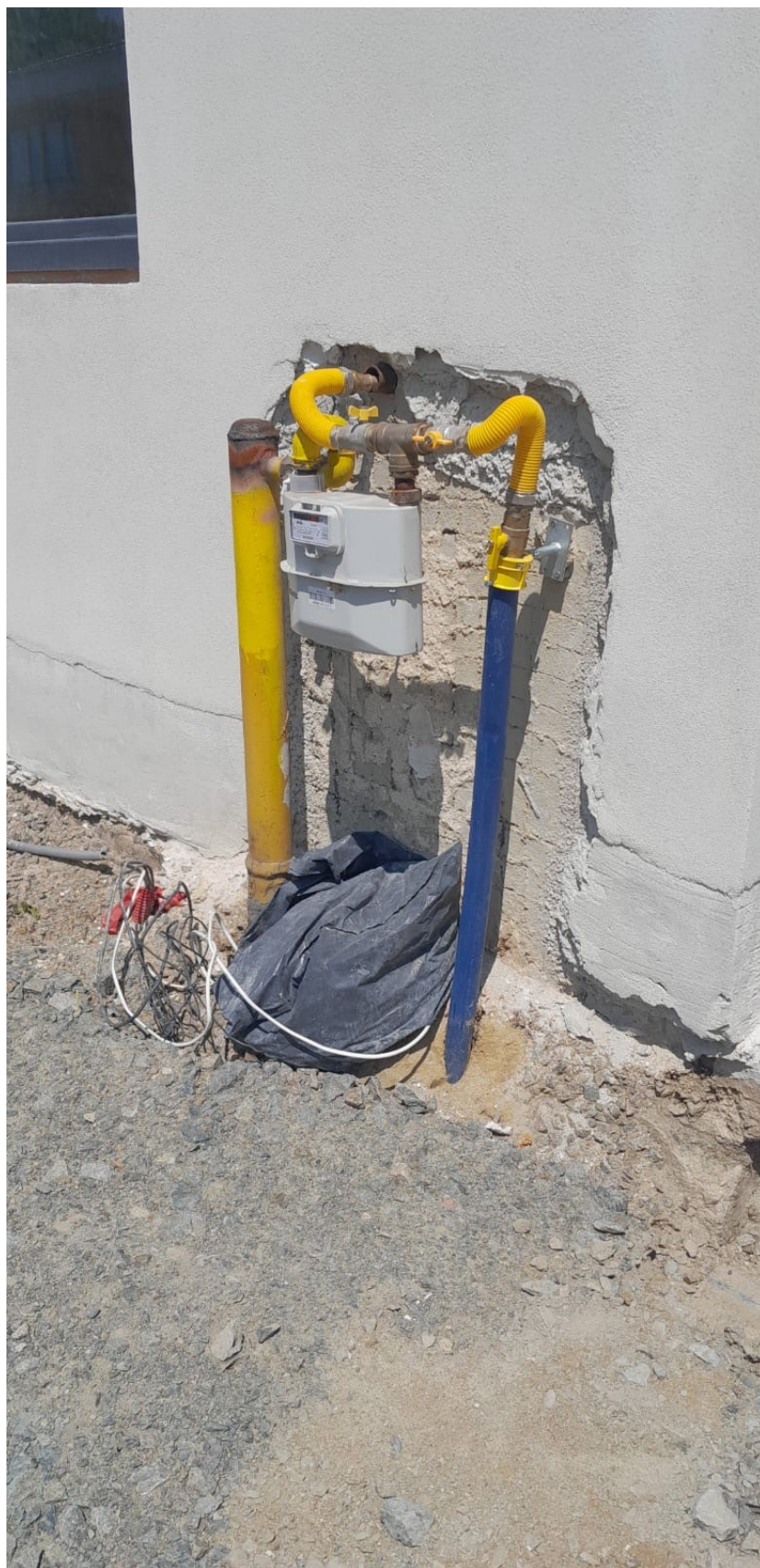
Místo kde se musela vyřešit oplechování hlavního uzávěru plynu
