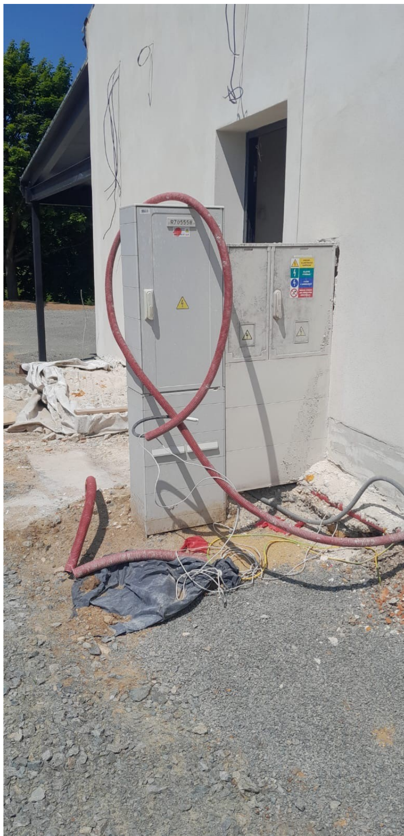
Místo kde se musela vyřešit oplechování rozvaděčů
