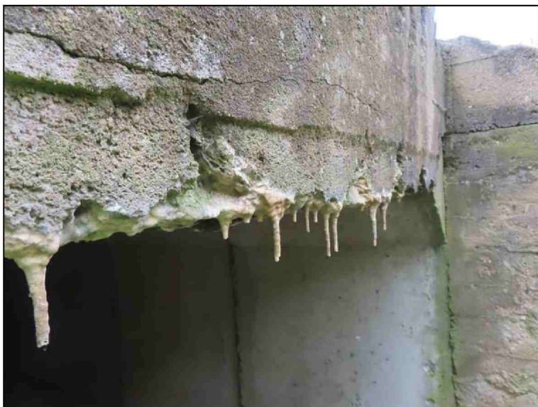
Pohled nad OP1 LS Příčel -projevy silného zatékání pod římsou- koroze výztuže
