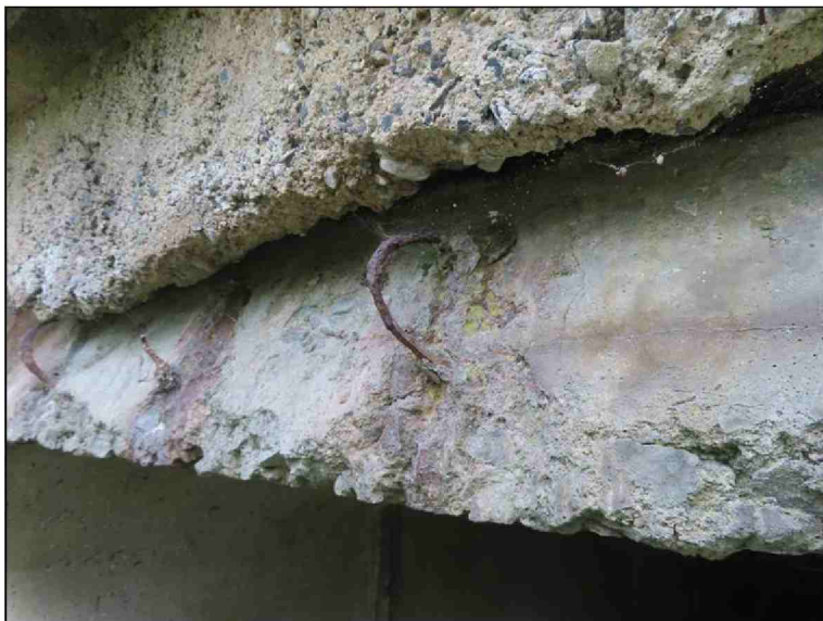
Pohled na OP2 a křídlo z PS Separace krycí vrstvy -křídlo
