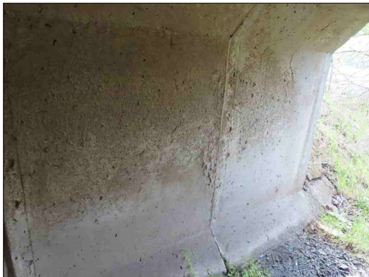
Pohled nad OP2 PS 11 díl- separace krycí vrstvy
