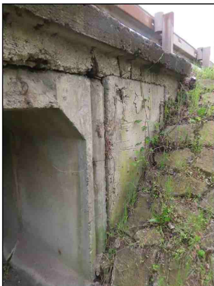
Pohled na OP2 a křídlo z PS Separace krycí vrstvy -křídlo
