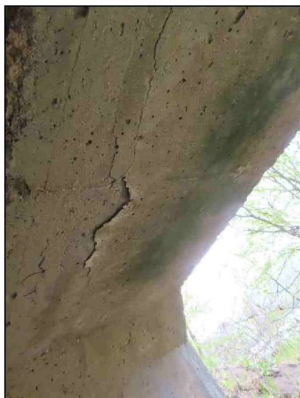
Pohled nad OP2 PS 11 díl- separace krycí vrstvy
