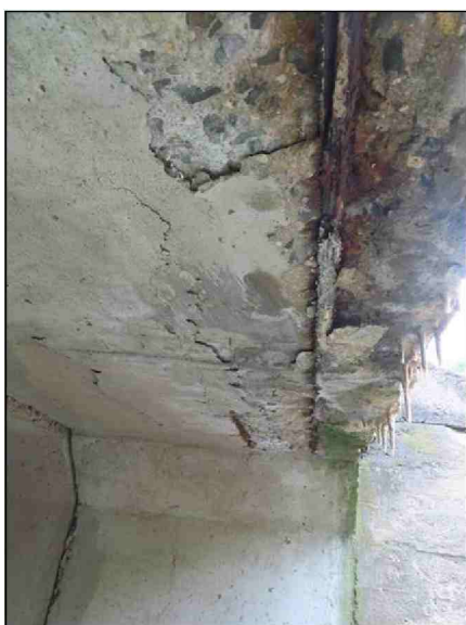
Pohled nad OP1 LS Příčel -projevy silného zatékání pod římsou- koroze výztuže
