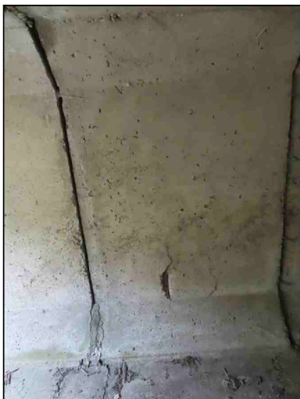
Pohled na OP2LS 3. díl -separace krycí vrstvy
