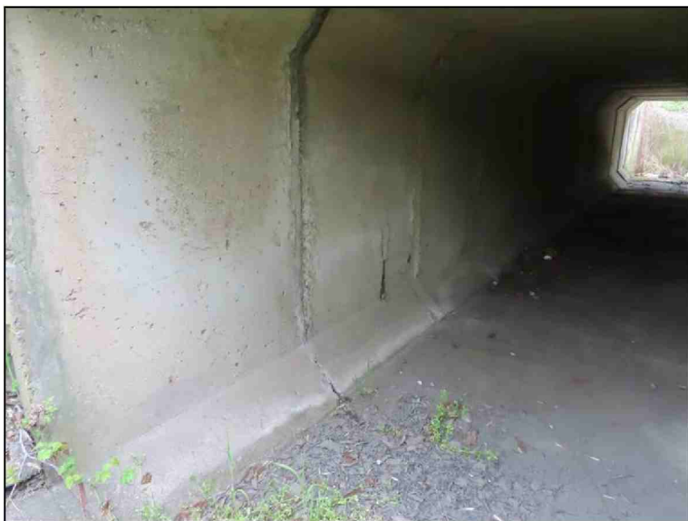
Pohled na OP1 z PS Separace krycí vrstvy
