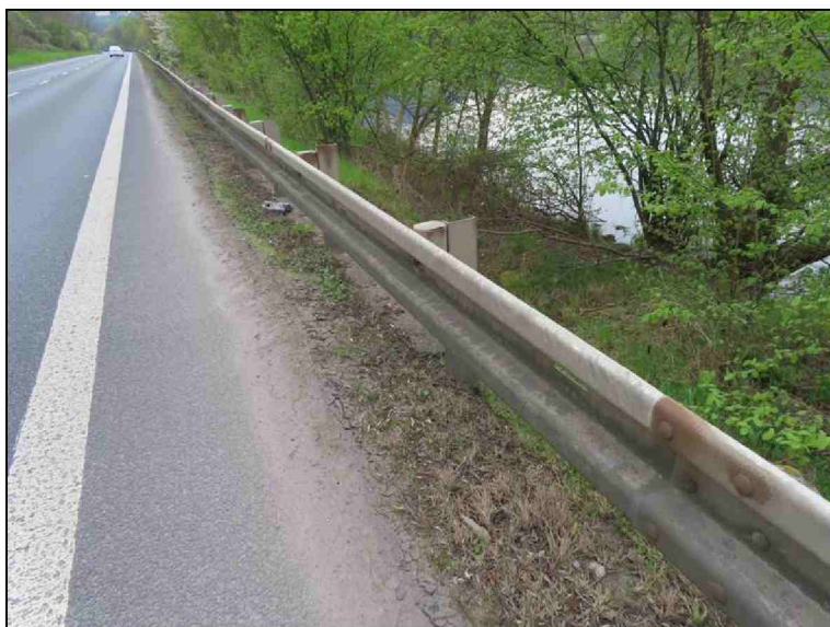
Pravá strana Svodidlo, deformační díl - koroze
