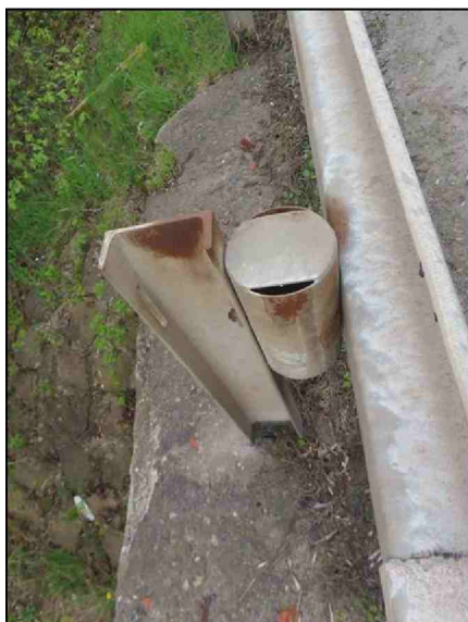
Pravá strana Svodidlo, deformační díl - koroze
