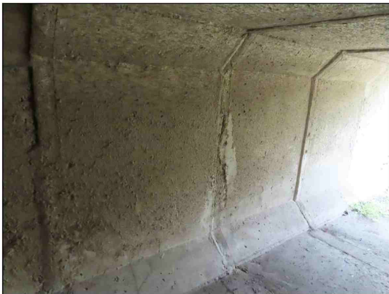
Pohled na OP2 PS 9-11 díl Separace krycí vrstvy
