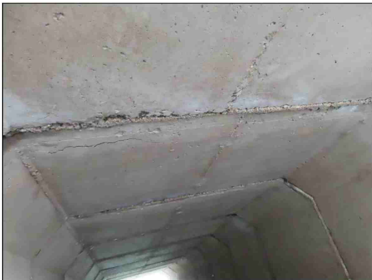
Pohled na OP2LS 3. díl -separace krycí vrstvy
