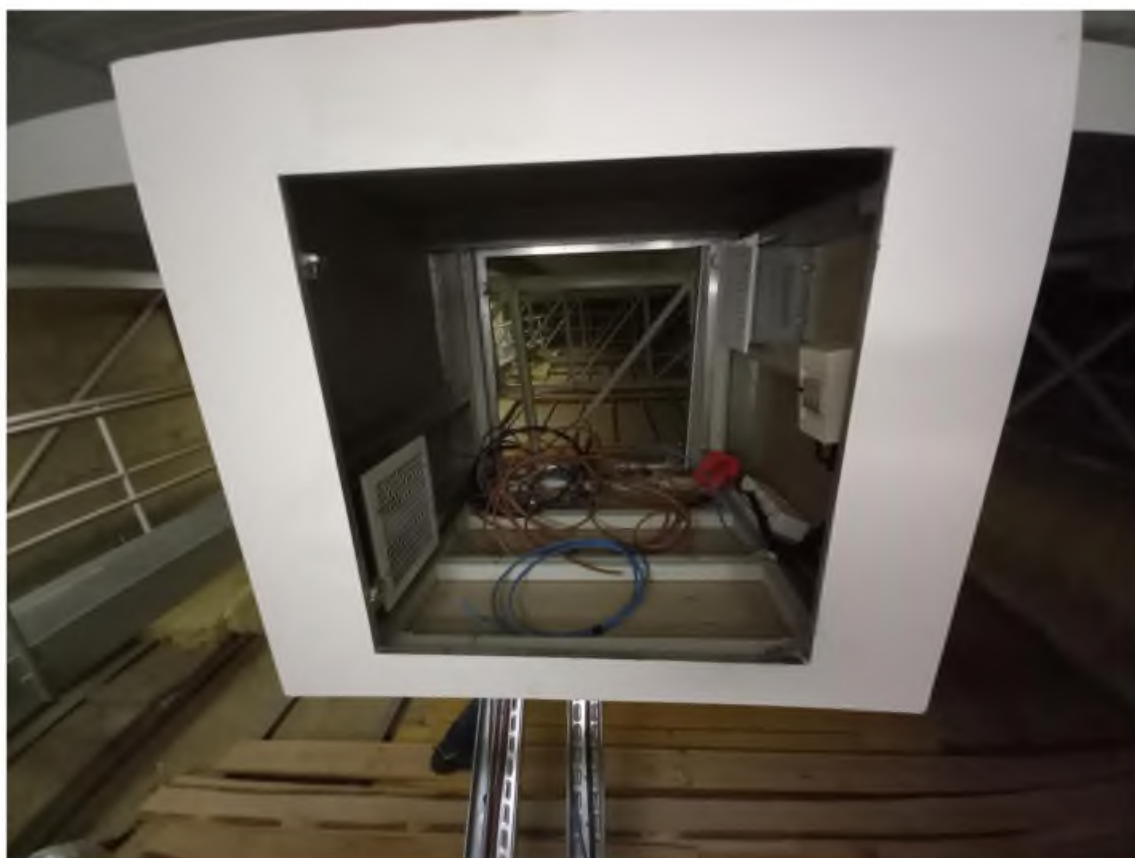
Obr č.5 – Stojan pro zesilovače exteriérových repro
