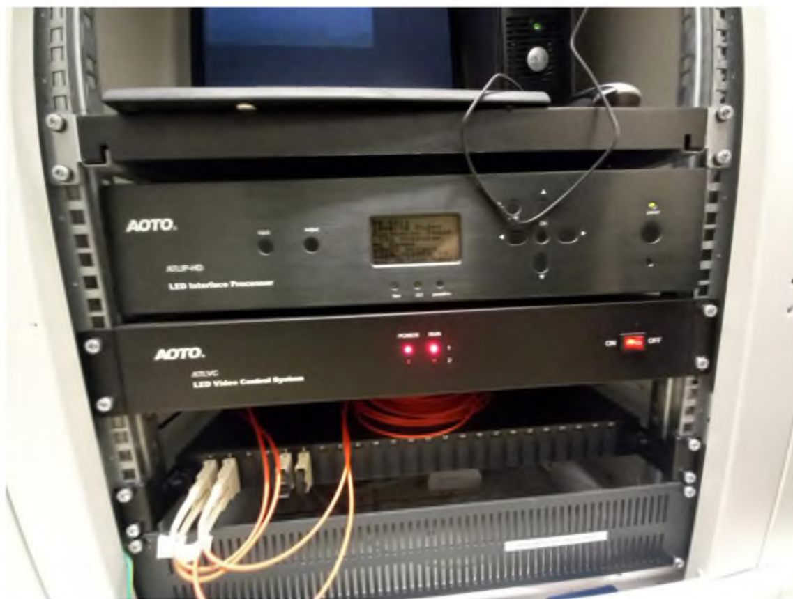
Obr. č.12 – AOTO LED videoprocesing a řízení
