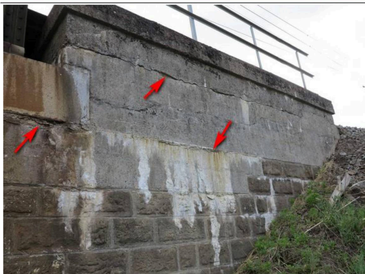
Foto č. 7 O 02 - úložný kvádr a křídlo vpravo, trhliny s průsaky a vápennými výluhy. Degradace betonu pod úložným kvádrem.
