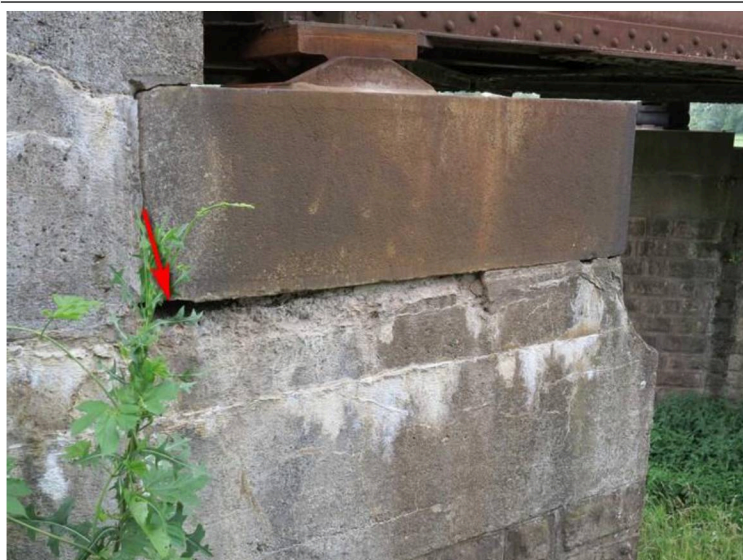
Foto č. 2 O 01 - úložný kvádr vpravo z líce, degradace betonu pod úložným kvádrem.
