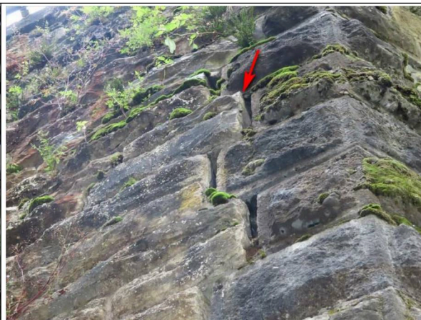
Foto č. 4 - O 01 - křídlo vpravo, odpojení zdiva detail včetně vysunutí až o 40 mm.
