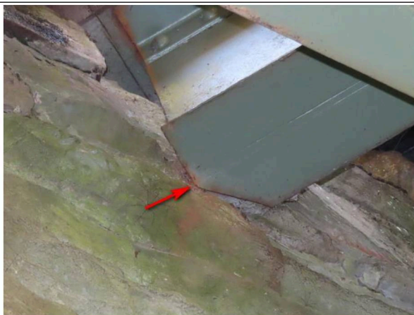
Foto č. 1 - K 01 - zapření levého podélníku do zdiva závěrné zdi nad O 01.
