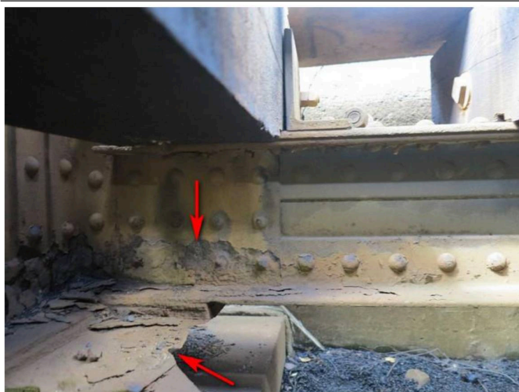
Foto č. 1 K 01 - podélník v 0. poli vpravo, korozní oslabení stojiny. Dále silné korozní oslabení stykové desky dolního podélného ztužení.
