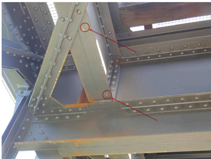
Obrázek 1. Konstrukce K 01 dolní úhelníky podélníků v místě napojení na příčník –
