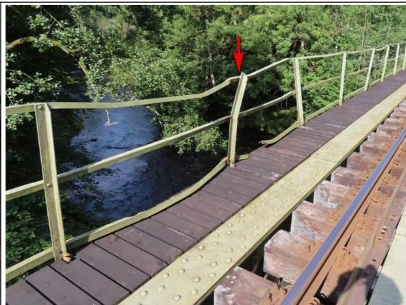
Foto č. 2 - K 01 - zábradlí vlevo na NK, silně deformované.
