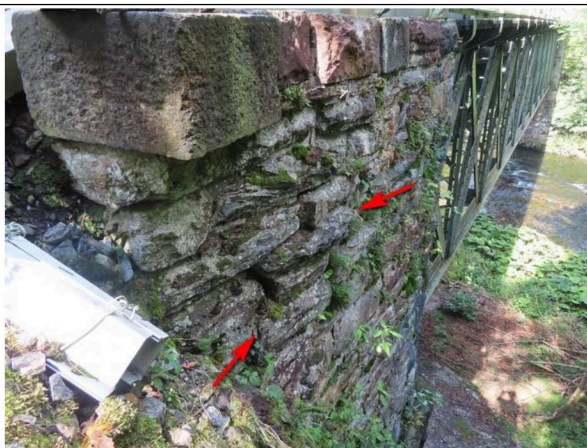
Foto č. 5 - O 01 - křídlo vpravo, v konci hloubkově vypadané spárování a vysunutí až o 100 mm.
