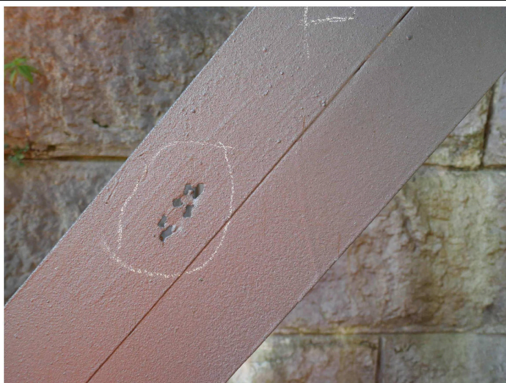
Obrázek 2. Konstrukce K 01 příhrada č. 1 vpravo na začátku –
