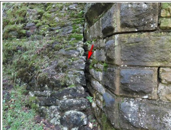
Foto č. 6 - O 01 - kamenný kozel vpravo, separace a rozevření spáry až o 150 mm.
