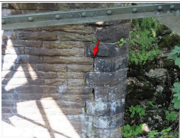
Foto č. 7 - O 02 - dřík z čela vpravo, svislá trhlina ve spáře včetně hloubkově vypadaného spárování.
