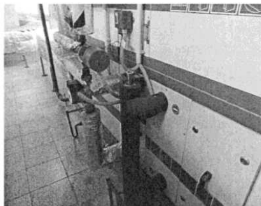
Obrázek 18: Napojení VZT na topnou a chladnou vodu
