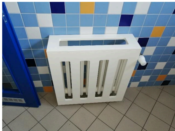
Obrázek 72 - Otopná tělesa v dřevěném ohrazení
