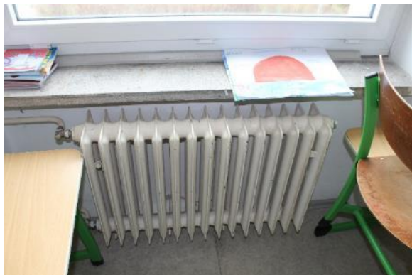
Obrázek 138 - Otopná tělesa v učebnách
