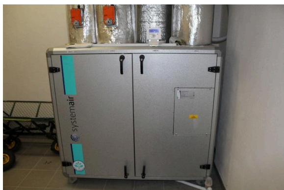
Obrázek 155 - Větrací jednotka
