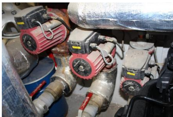
Obrázek 137 - Oběhová čerpadla na rozdělovači
