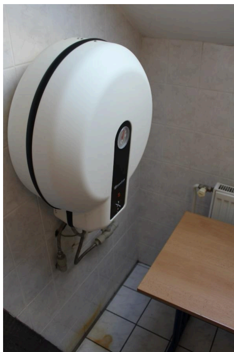
Obrázek 124 - Průtokový el. ohřívač Dražice TO2
