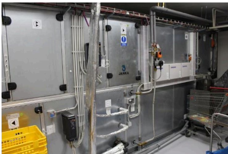
Obrázek 140 - VZT jednotka pro kuchyň
