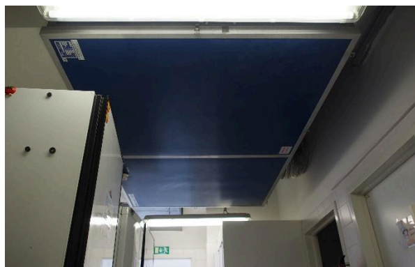
Obrázek 64 - Větrací jednotka pro kuchyň
