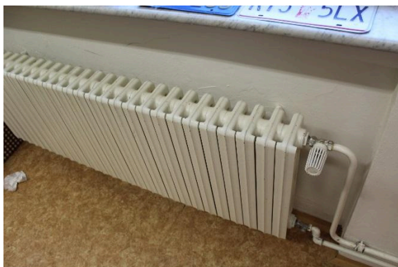
Obrázek 91 - Litinová otopná tělesa v budově
