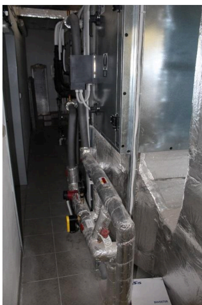
Obrázek 49 - VZT jednotka pro kuchyň, pohled A
