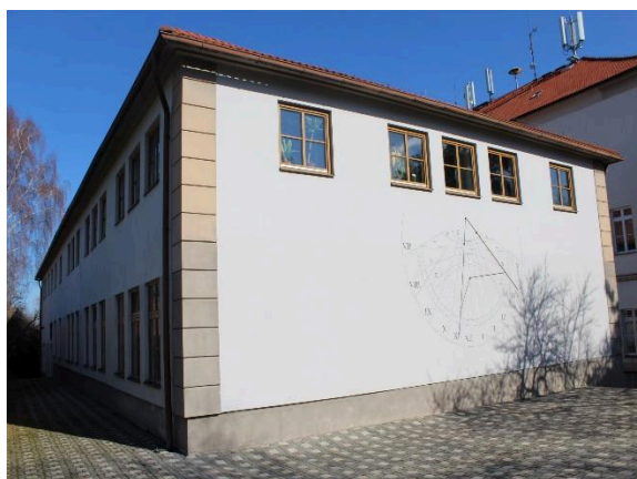
Obrázek 116 - Pohled na levé křídlo
