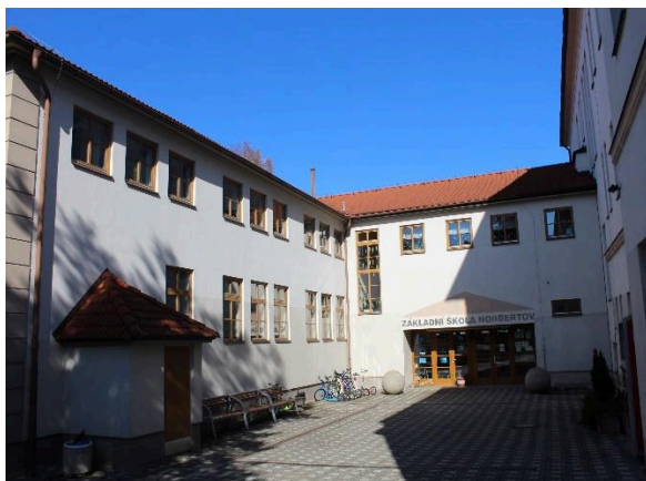
Obrázek 115 - Pohled na vchod do budovy
