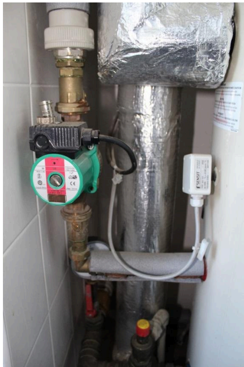
Obrázek 154 - Cirkulační čerpadlo TV
