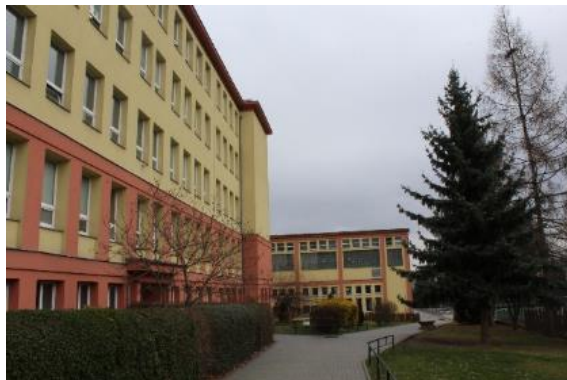
Obrázek 134 - Objekt A, pohled na objekt B
