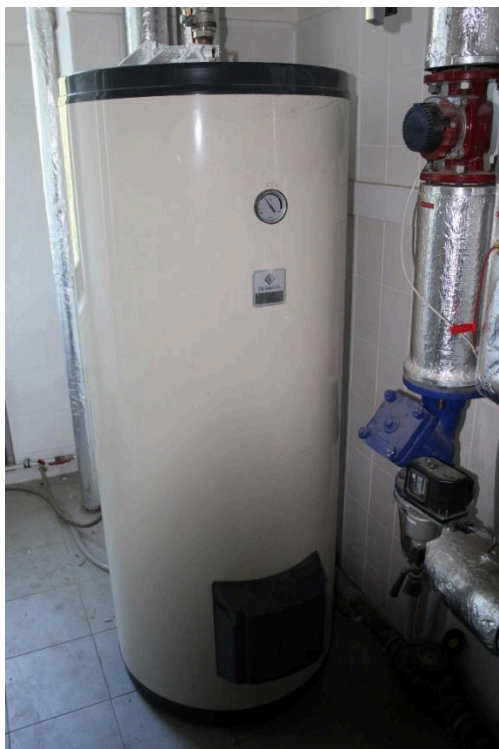
Obrázek 153 - Zásobníkový ohřívač TV
