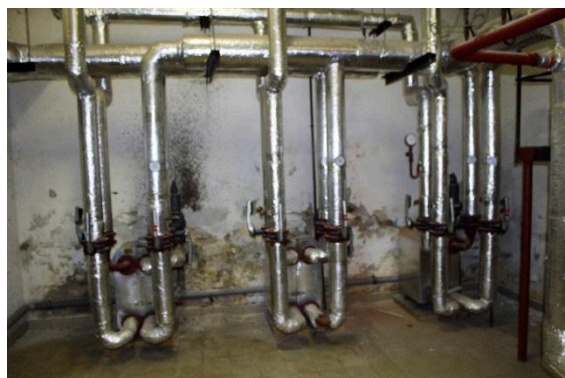
Obrázek 88 - Deskové výměníky - celkový pohled
