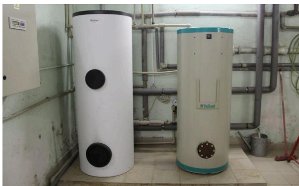
Obrázek 24 - Příprava TV - Hlavní budova ZŠ
