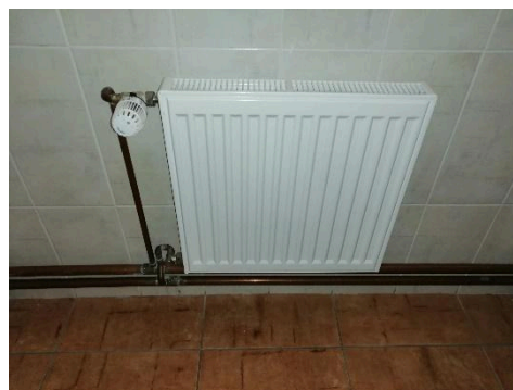
Obrázek 83 - Ocelové deskové těleso
