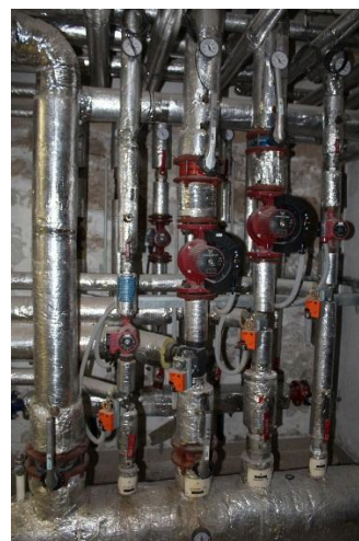
Obrázek 90 - Oběhová čerpadla
