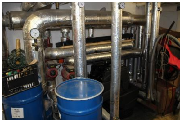
Obrázek 136 - Podružný rozdělovač v objektu A
