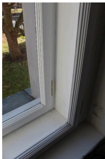
Obrázek 114 - Detail okna v původní budově
