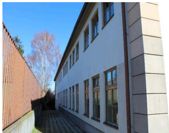
Obrázek 117 - Boční pohled na budovu
