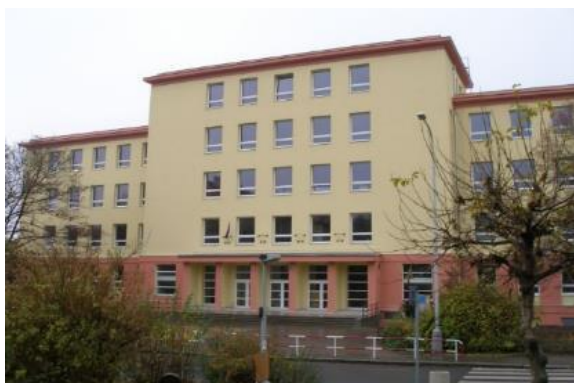
Obrázek 131 - Objekt A – hlavní budova, vstup
