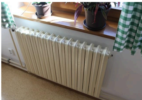
Obrázek 122 - Otopná tělesa v jídelně
