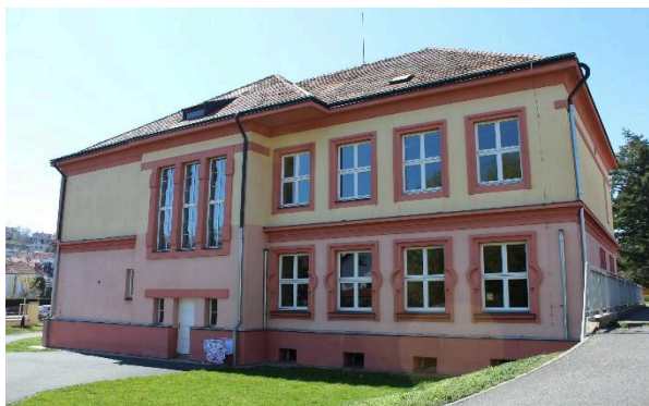
Obrázek 8 – Pohled II – vedlejší budova ZŠ
