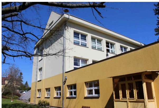
Obrázek 3 - Pohled III - hlavní budova ZŠ
