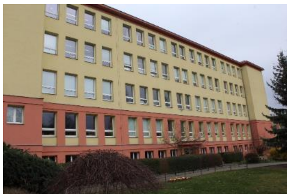
Obrázek 132 - Objekt A, severní pohled
