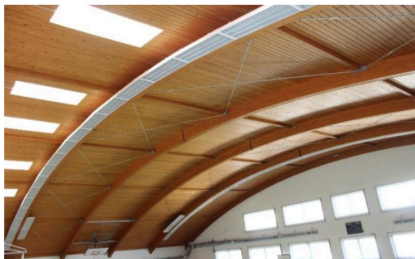
Obrázek 35 - Osvětlení tělocvičny haly
