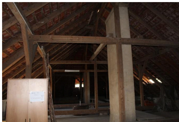
Obrázek 10 – Vedlejší budova ZŠ
