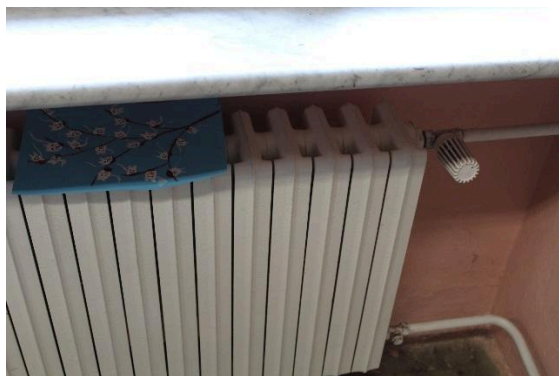
Obrázek 45 - Litinová otopná tělesa v budově
