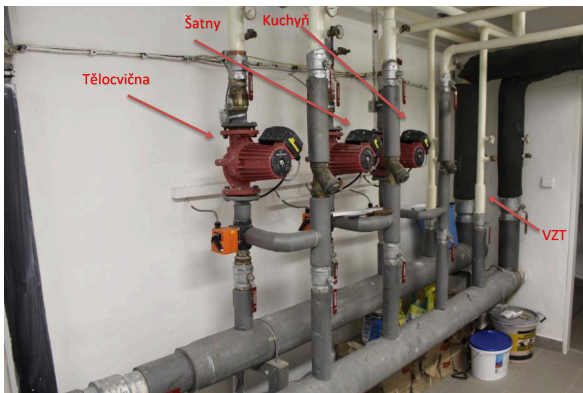
Obrázek 135 - Hlavní rozdělovač v objektu B
