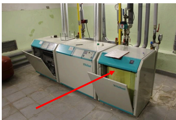
Obrázek 26 – Příprava TV – Vedlejší budova ZŠ
