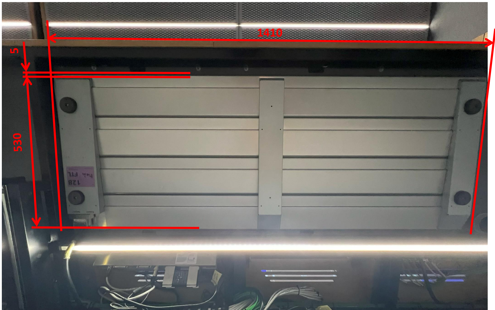
Obr. 3 – Rozměry stávajícího ovládacího panelu, pohled zespoda
