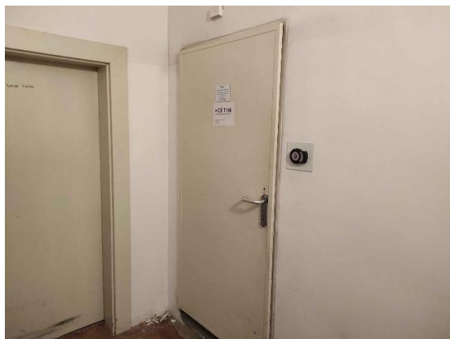
Vstup do chodby S033 z chodby S028
