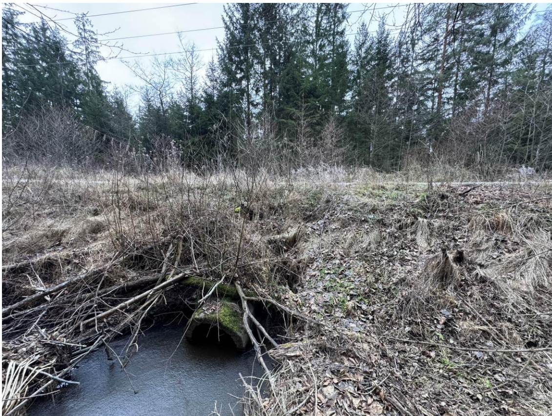
Obrázek 3: propust pod LC
