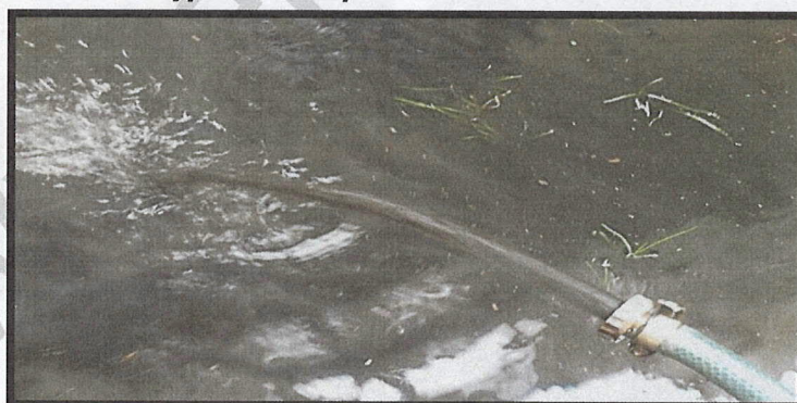
Vypuštění rozpuštěného nánosů z ÚT:
