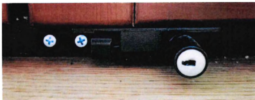
Obr. 4 - Uzamykatelné zarážky oken - možný vzor – umožňuje otevření okna pouze na ventilačku
