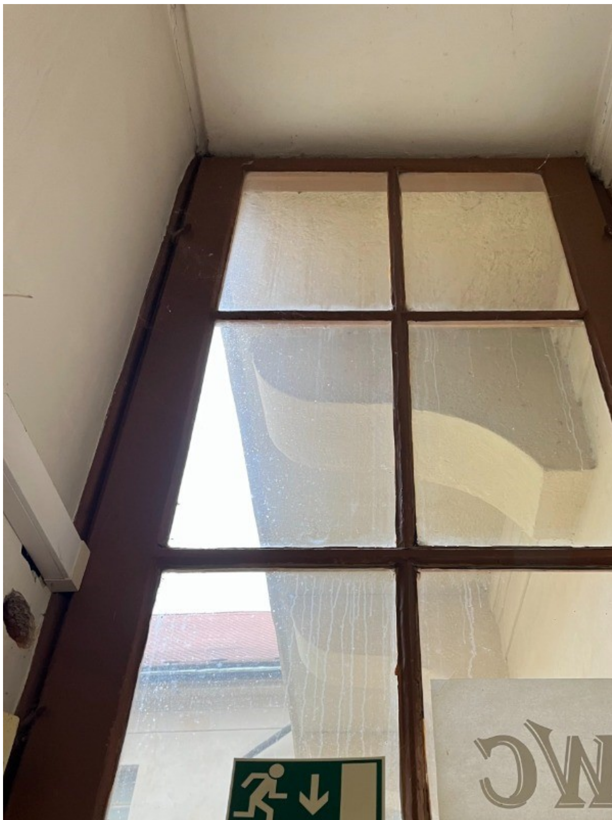
Pohled na nadsvětlík z interiéru
