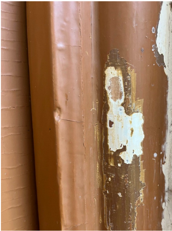
Detail průzkumu nátěrů na obložkách a nadsvětlíku
