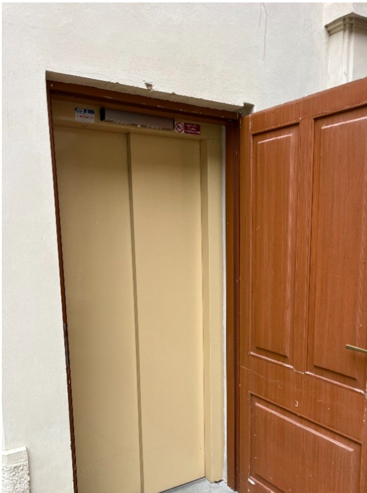
Pohled na vnitřní stranu dveří
