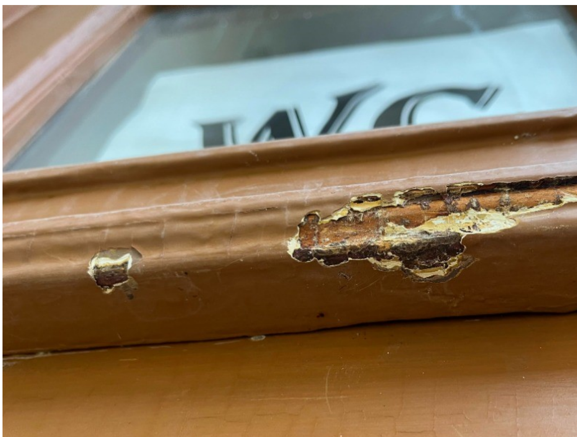
Průzkum nátěrů rámu nadsvětlíku
