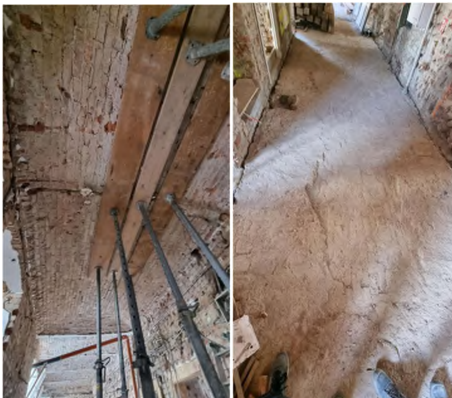
Pohled na konstrukci
