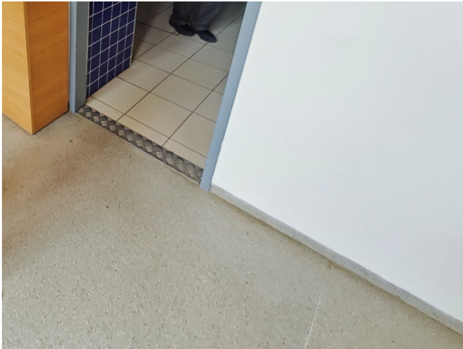
Nerezový přechodový práh mezi Předsíní D109 a chodbou D190
