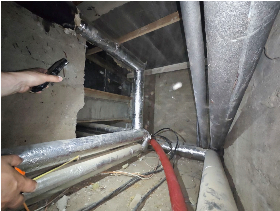
Zalomení kolektoru na přechodu do atria
