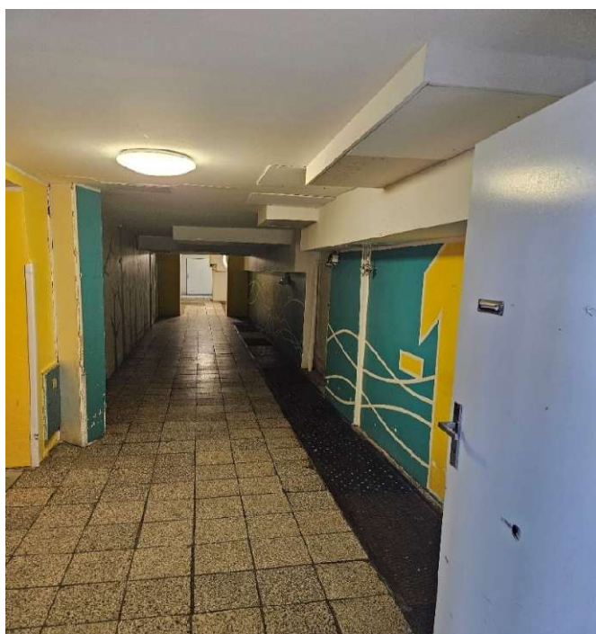
Stav přístupové cesty na příjmovou ambulanci
