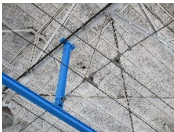
Obr. 26: Trakční vedení na nosné konstrukci budovy
