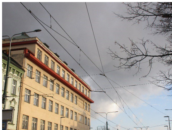
Obr. 10: Pevný bod řetězového vedení
