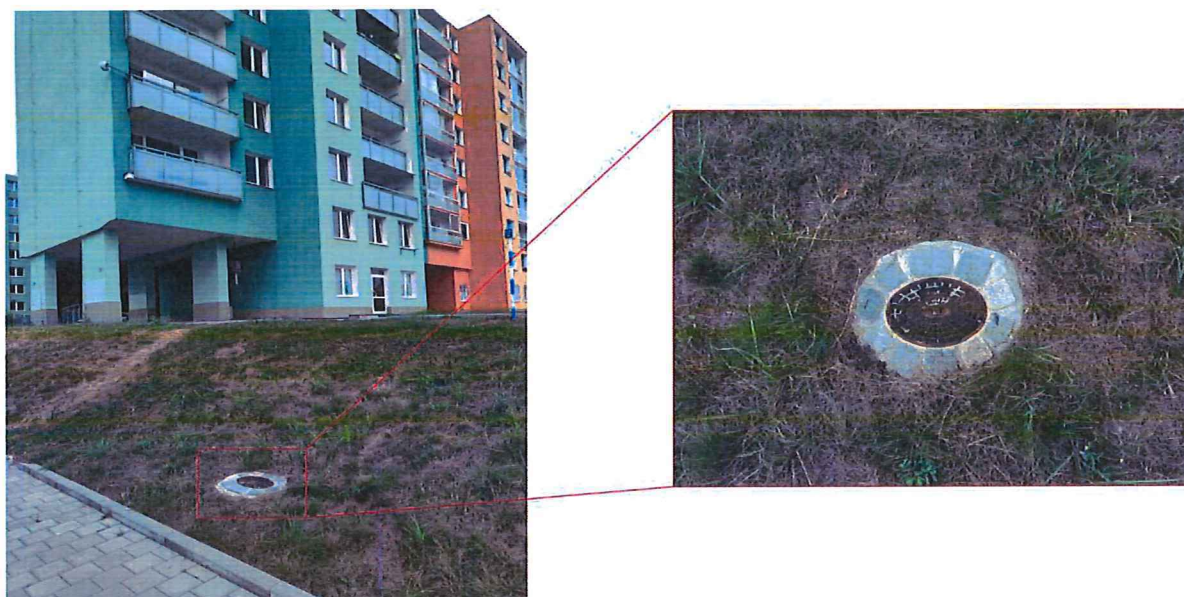
Obrázek 5: Doporučená finální úprava zhlaví vrtu po dokončení stavebních prací
