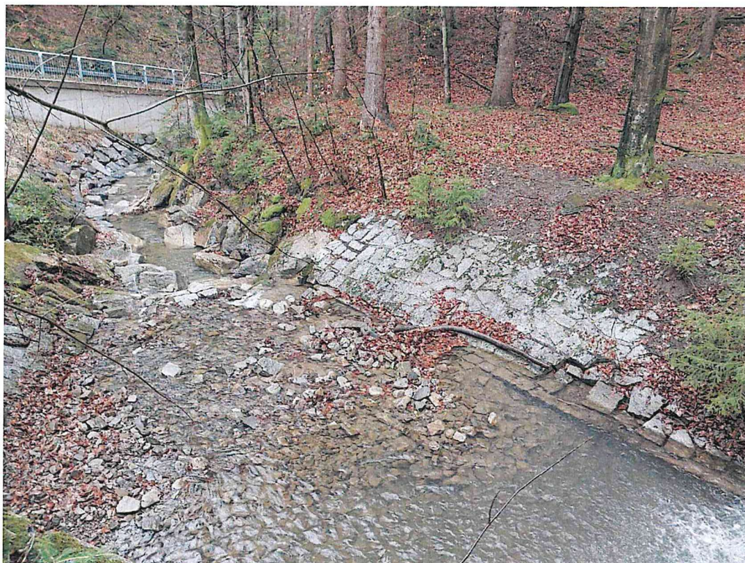
Obrázek 3 Zanesené dopadiště splaveninami
