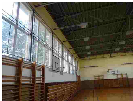
Objekt A – tělocvična - ocelový krov střechy tělocvičny
