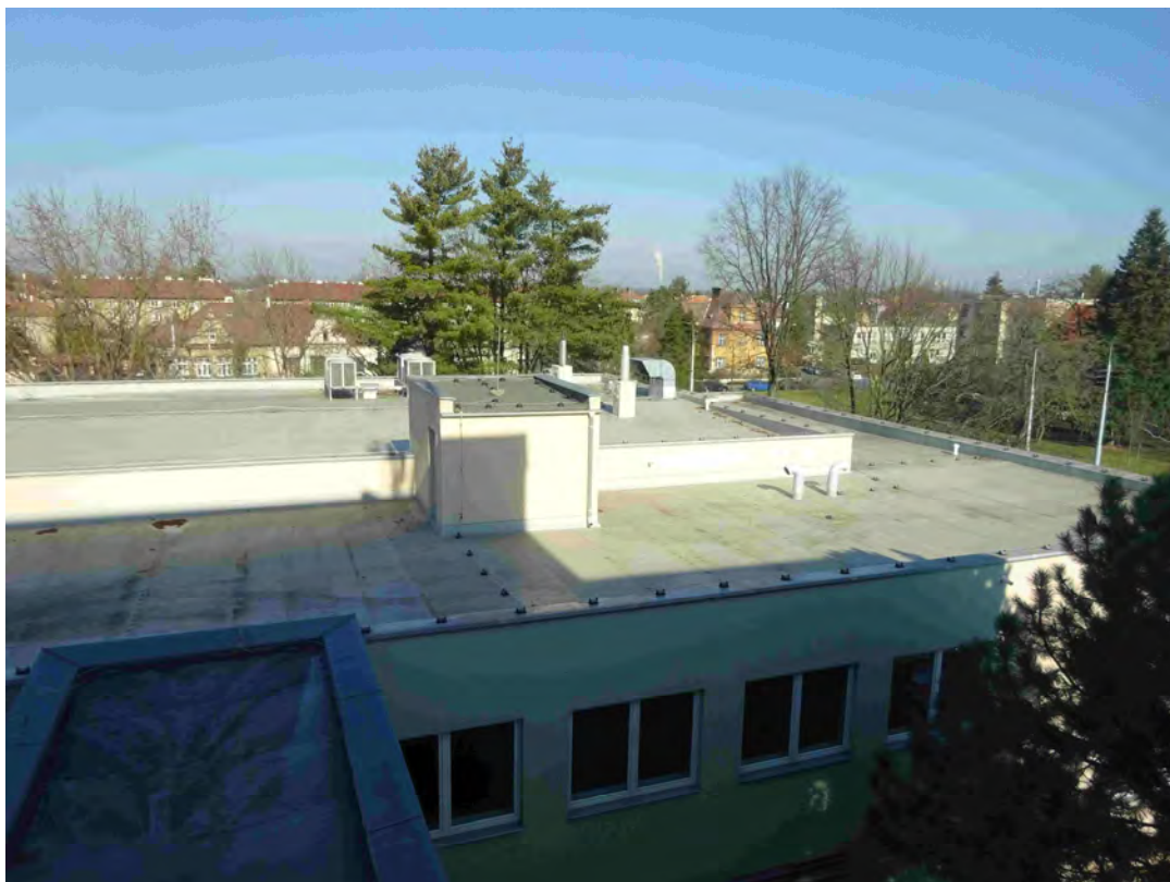
Pohled na střešní plášť jídelny
