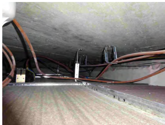
Objekt C - Stropní konstrukce přístavby šaten
