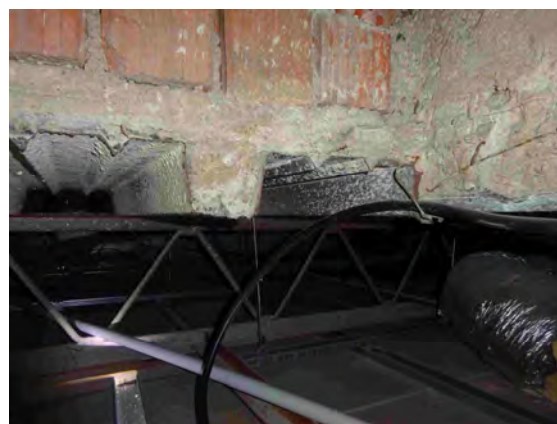
Objekt B - Pohled na skladbu střechy
