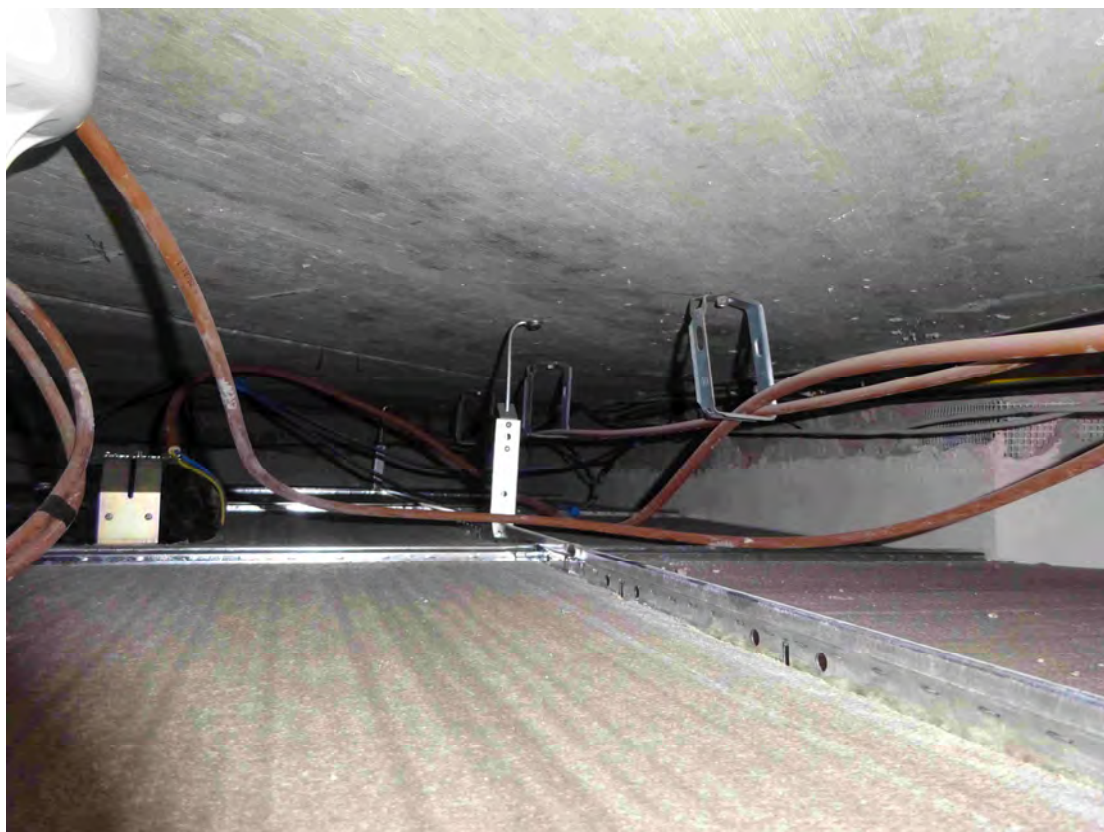
Monolitická stropní konstrukce přístavby
