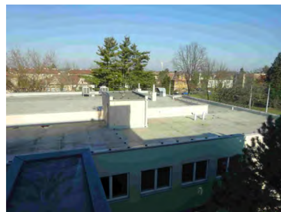
Objekt B - Pohled na střešní plášť jídelny
