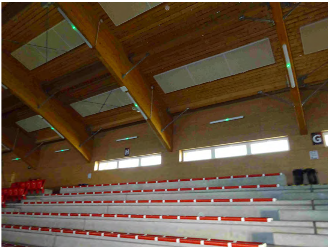
Střešní konstrukce sportovní haly
