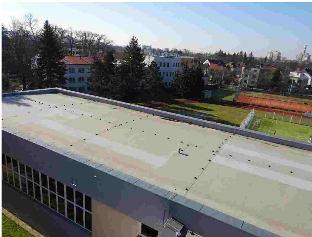
Plochá střecha tělocvičny
