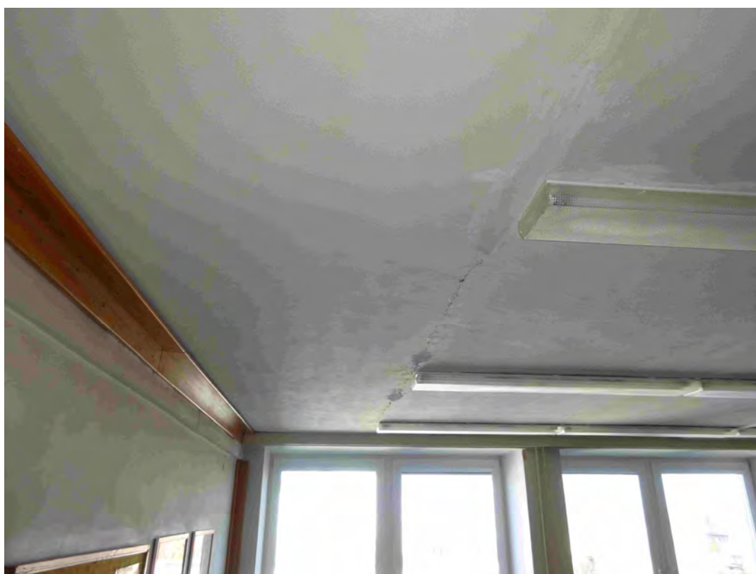
Trhlina u stropního panelu přiléhajícího ke štítové stěně
