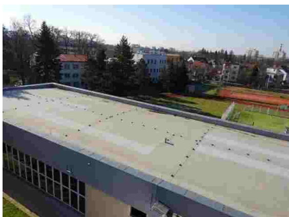
Objekt A - Plochá střecha tělocvičny
