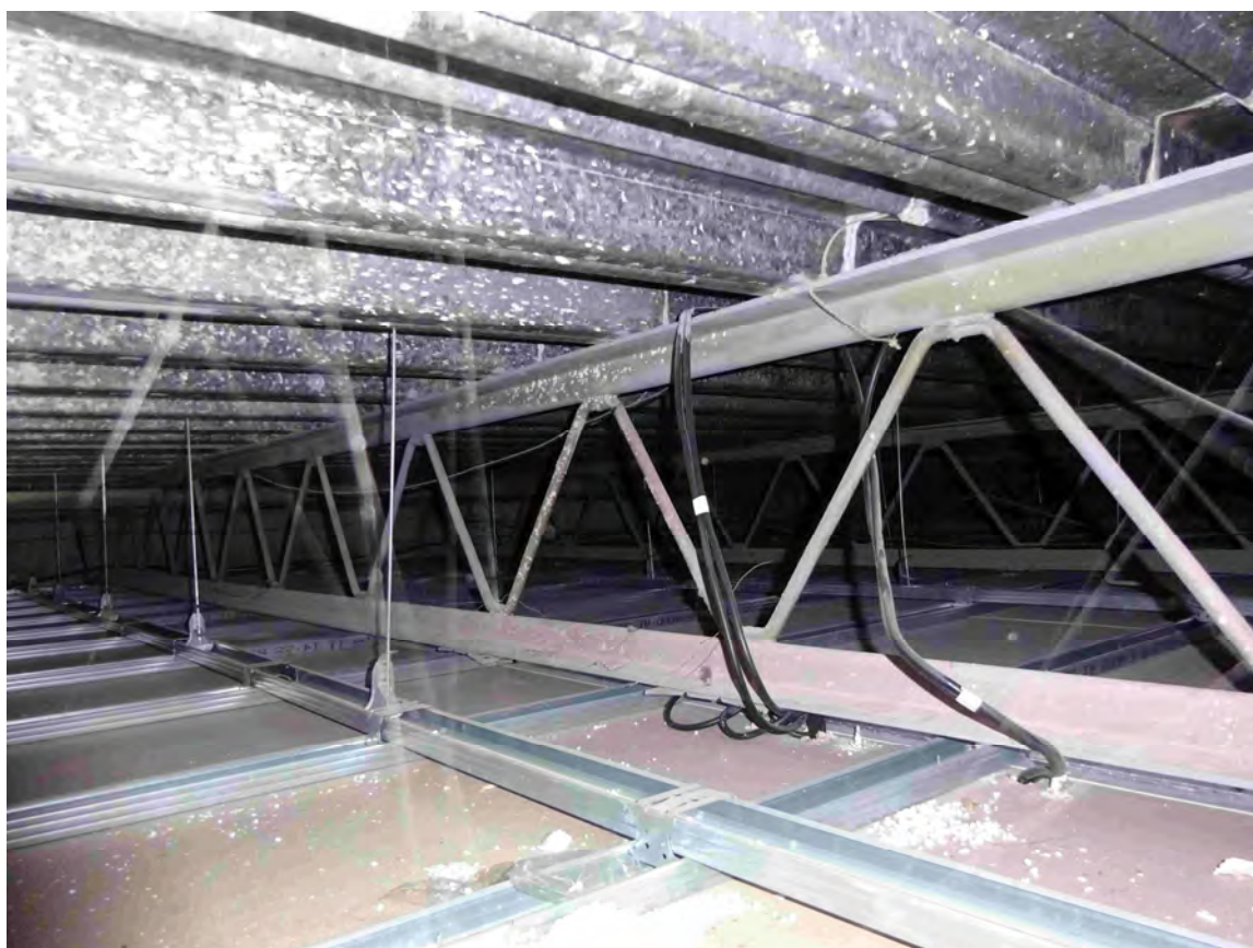
Pohled střešní konstrukce nižší části střechy
