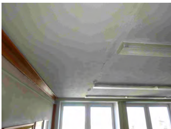
Objekt A – škola - trhлина u stropního panelu přiléhajícího ke štitové stěně
