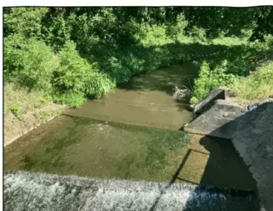
Obr.: ř.km 4,148 Dnový stupeň Temešvár
