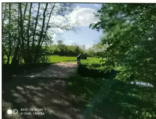
Obr.: ř.km 3,907 Most v oblasti navrhované Jižní spojky
