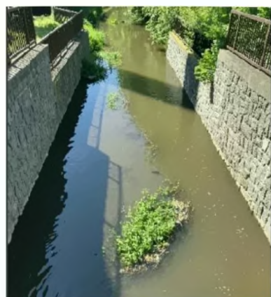
Obr.: ř.km 4,416 Úsek vodního toku pod Temešvárem
