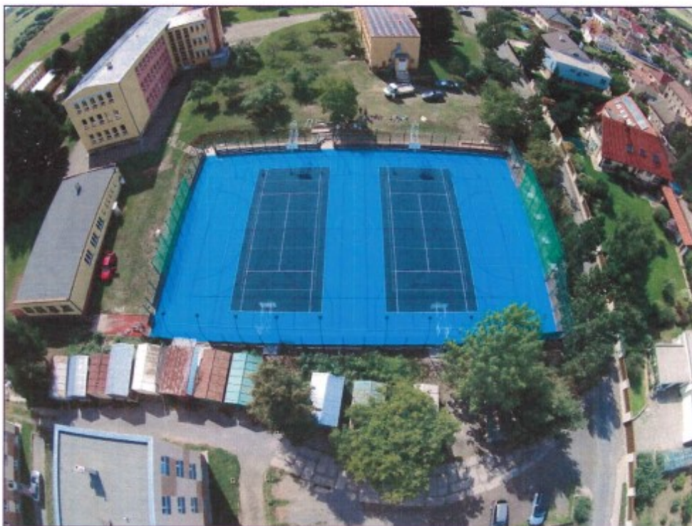
Víceúčelový sportovní areál ZŠ Praha – Řeporyje
