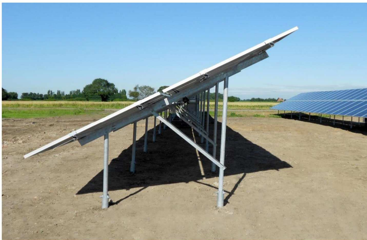
Obrázek 3: Umístění panelů na roznášecí konstrukci
