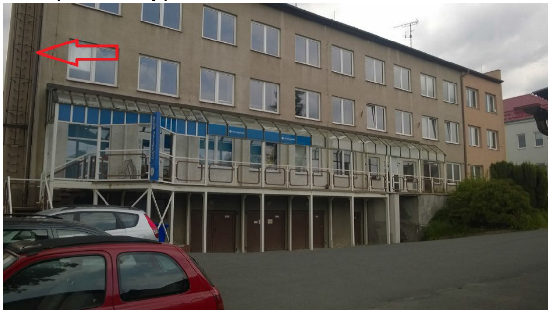
Foto 1: celkový pohled na objekt ÚzP v Hlinsku, červená šipka označuje přístupovou část na povrch střechy pomocí stěnového žebříku
