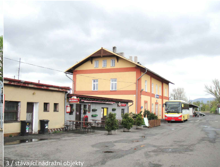
3 / stávající nádražní objekty
