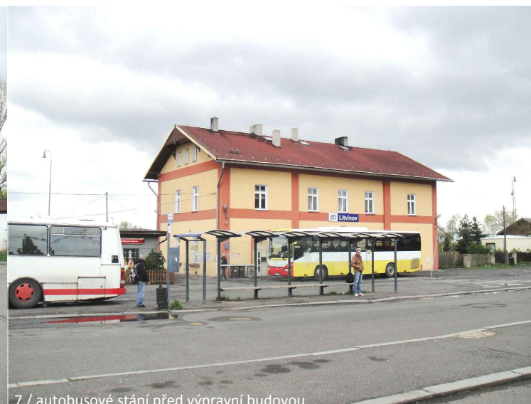
7 / autobusové stání před výpravní budovou
