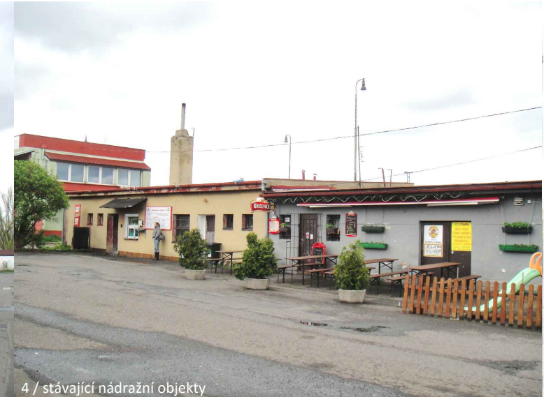
4 / stávající nádražní objekty
