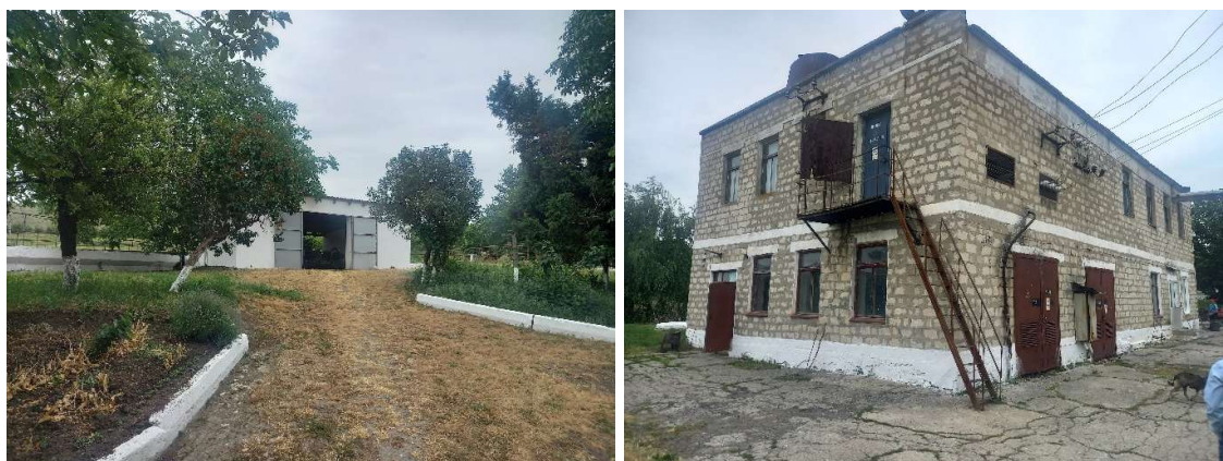
Obr. 8 Fotodokumentace čistírny odpadních vod, fotodokumentace ze dne 27. 05. 2024
