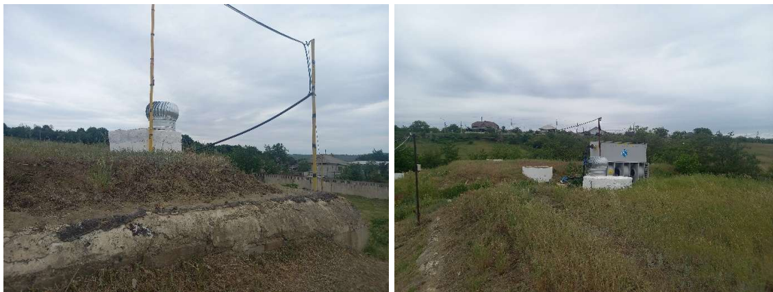
Obr. 11 Fotodokumentace vodojemu 2 x 1000 m 3 , fotodokumentace ze dne 27. 05. 2024
