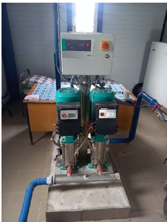
Obr. 5 Fotodokumentace zdrojů surové vody v lokalitě Firladeni: 4 x vrt a akumulace 2 x 75 m 3 s čerpací stanicí surové vody, fotodokumentace provedená dne 27. 05. 2024
