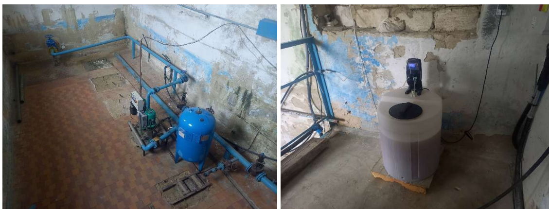
Obr. 12 Fotodokumentace vodojemu 2 x 1000 m 3 , fotodokumentace ze dne 27. 05. 2024
