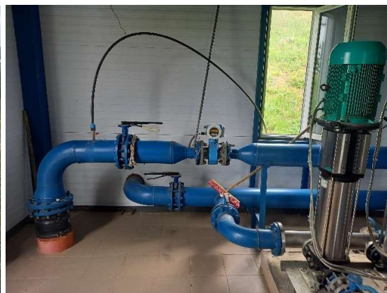
Obr. 4 Fotodokumentace zdrojů surové vody v lokalitě Firladeni: 4 x vrt a akumulace 2 x 75 m 3 s čerpací stanicí surové vody, fotodokumentace provedená dne 27. 05. 2024
