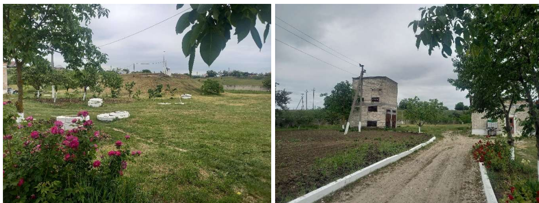
Obr. 10 Fotodokumentace vodojemu 2 x 1000 m 3 , fotodokumentace ze dne 27. 05. 2024
