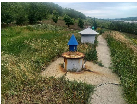
Obr. 4 Fotodokumentace zdrojů surové vody v lokalitě Firladeni: 4 x vrt a akumulace 2 x 75 m 3 s čerpací stanicí surové vody, fotodokumentace provedená dne 27. 05. 2024
