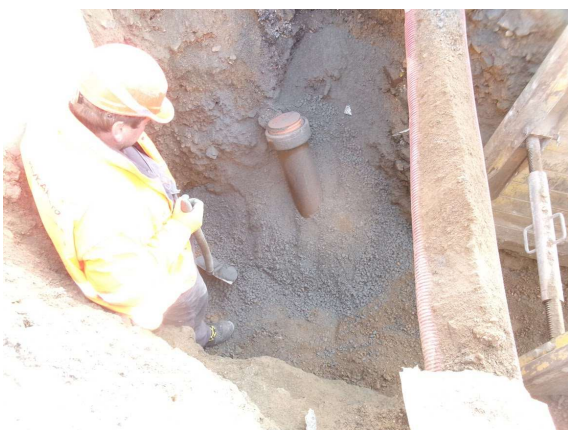
Umístění kanalizační odbočky pro napojení uliční vpustě u šachty Š1160.
