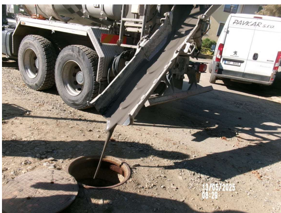
Zalívání kanalizace cementovo-popílkovou směsí.
