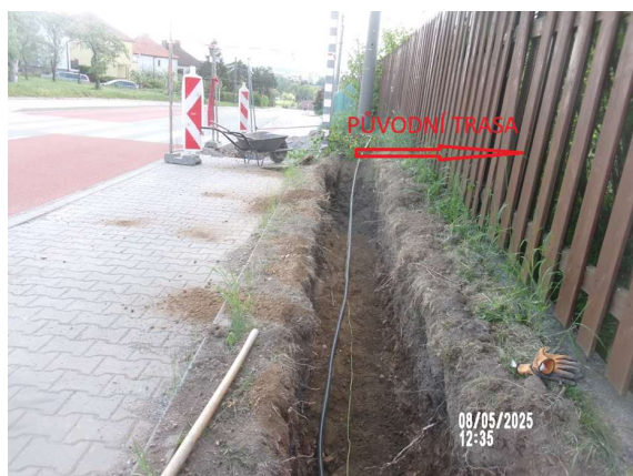
Změna trasy vodovodní přípojky č.p.: 328 – vedení v zeleném pásu obecního pozemku.
