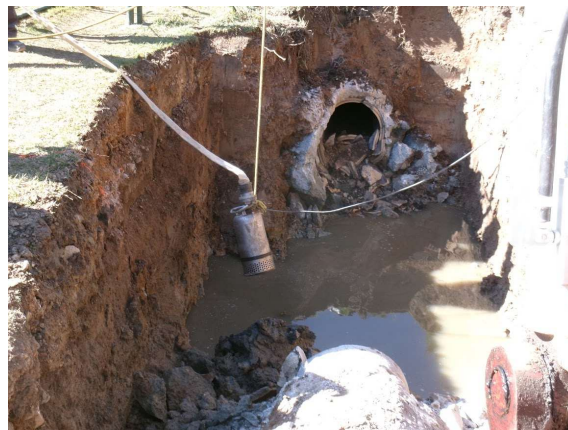
Bourání a úprava stávající kanalizace v místě napojení u šachty Š1158.
