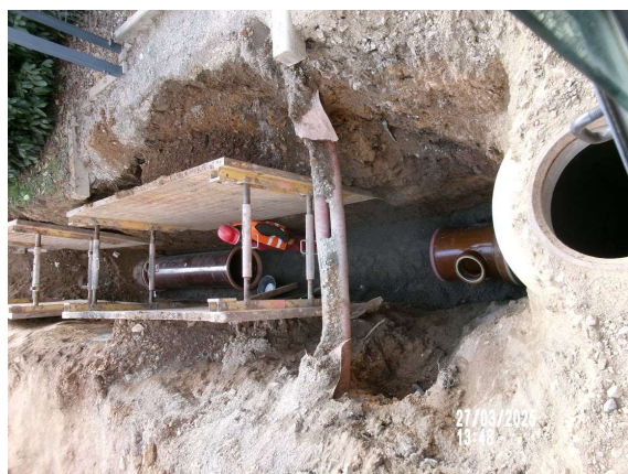
Umístění kanalizační odbočky pro napojení uliční vpustě u šachty Š1160.
