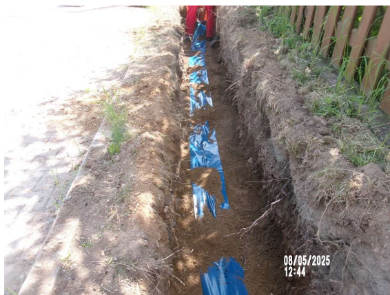
Změna trasy vodovodní přípojky č.p.: 328 – vedení v zeleném pásu obecního pozemku.
