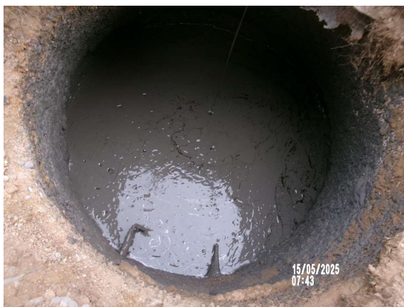
Zalívání kanalizace cementovo-popílkovou směsí.
