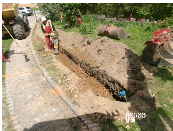
Změna trasy vodovodní přípojky č.p.: 328 – vedení v soukromé části vlastníka nemovitosti.
