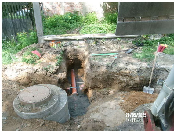
Umístění kanalizační odbočky pro napojení uliční vpustě u šachty Š1160.
