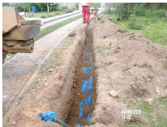
Změna trasy vodovodní přípojky č.p.: 328 – vedení v soukromé části vlastníka nemovitosti.
