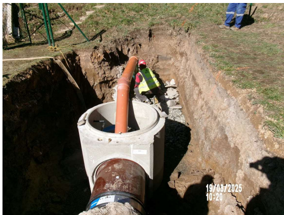
Bourání a úprava stávající kanalizace v místě napojení u šachty Š1158.
