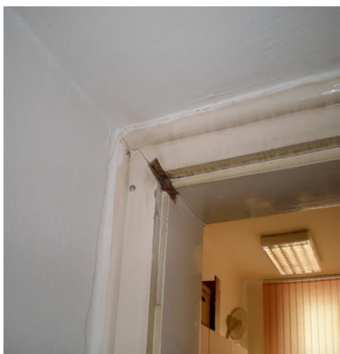
Detail stávající zárubně
